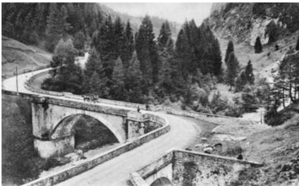
Abb. 1: Das imposante Gewölbe der Rania-Brücke, gebaut nach dem Hochwasser von 1834: «Es ist diese wohl eine der grössten Öffnungen, welche mit nicht regelmässig nach dem Fugenschnitt, sondern bloss mit zugeordneten Bruchsteinen überwölbt worden sind. Das Werk ist von Sachkennern als vollkommen gelungen erklärt worden.»
