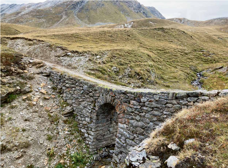
4 Steinbogenbrücke des Militärwegs aus dem Ersten Weltkrieg am Umbraillpass (IVS GR 2300). Solche Wegelemente von besonders prägendem Charakter sollen künftig in der Inventarkarte besser verortet und dokumentiert werden. (Foto: E. Flückiger, 2022)
