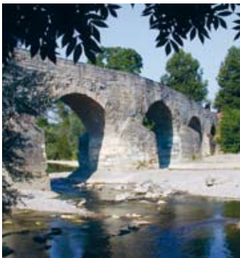
Instandsetzung und eingeschränkte Weiterverwendung: Die spätmittelalterliche Thurbrücke von Bischofszell TG wurde 2000–2005 mit Mauerwerksicherung, Abdichtung und Entwässerung sowie fussgängerfreundlichem Fahrbahnbelag renoviert (Andres Betschart).
