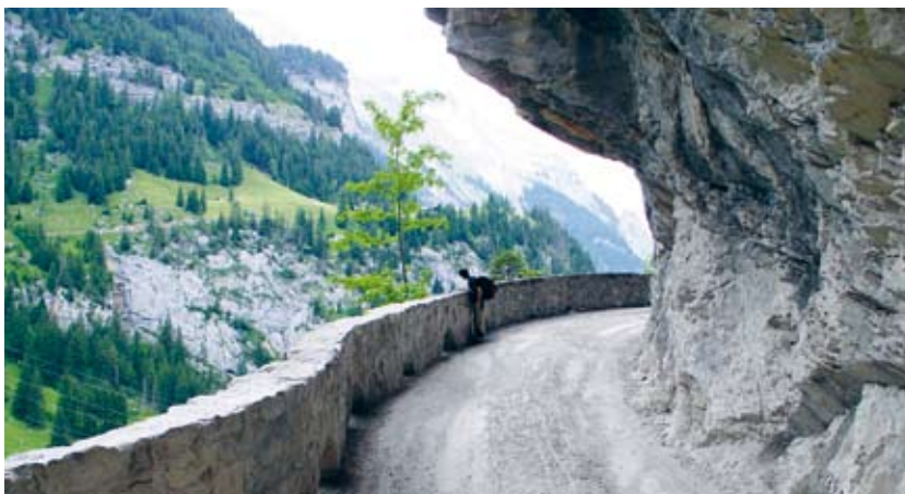
Diese Halbgalerie überdeckt die Strasse nahezu in ihrer ganzen Breite. Gasterenstrasse, Kandersteg BE (ViaStoria/Guy Schneider).
