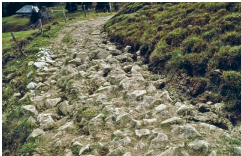
Das grobe Steinbett dieses geschotterten Fahrwegs trägt die Wegdecke in einer Feuchtestelle. Nünalp, Giswil OW (ViaStoria/ Arne Hegland).
