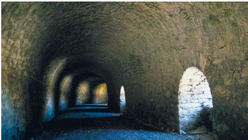
Seltenes Beispiel einer historischen Lawinengalerie aus dem 19. Jahrhundert: gemauertes Rundtonnengewölbe aus lagig geschichteten Bruchsteinen, Lichtschächte mit zugehauenen Bogensteinen gefasst. Splügenpass GR (ViaStoria/Arne Hegland).
