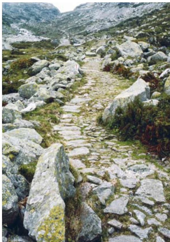
Der Gotthard-Saumpfad auf dem Mätteli zwischen Hospental UR und der Passhöhe. Nach der Freilegung ist die Struktur der Pflasterung beispielhaft sichtbar geworden (ViaStoria/Heinz Dieter Finck).
