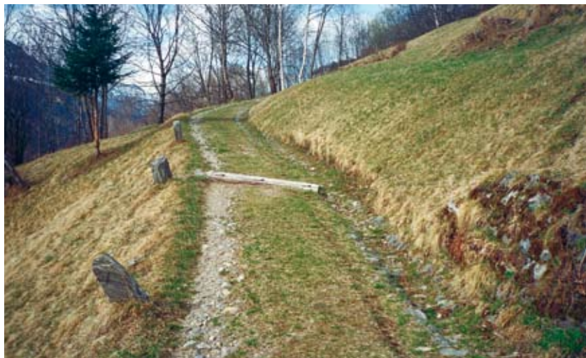
Oberhalb Poz ist der Karrweg von Arvigo nach Braggio im Calancatal GR als Hangweg mit beidseitigen Böschungen ausgebildet. Weitere Wegelemente: hangseitige Stützmauer, Querabschlag, Kolonnensteine (ViaStoria/Guy Schneider).
