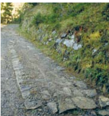
Dieser Karrweg mit Plattenpflaster wurde durch Aufschotterung zu einem Fahrweg verbreitert. Alpnach OW (ViaStoria/Guy Schneider).
