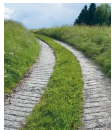
Ein geschickt als Spurweg ausgebauter Bewirtschaftungsweg mit Fahrspuren aus Beton, die mit Querrillen griffiger gemacht wurden. Fahrni BE (ViaStoria/Guy Schneider).
