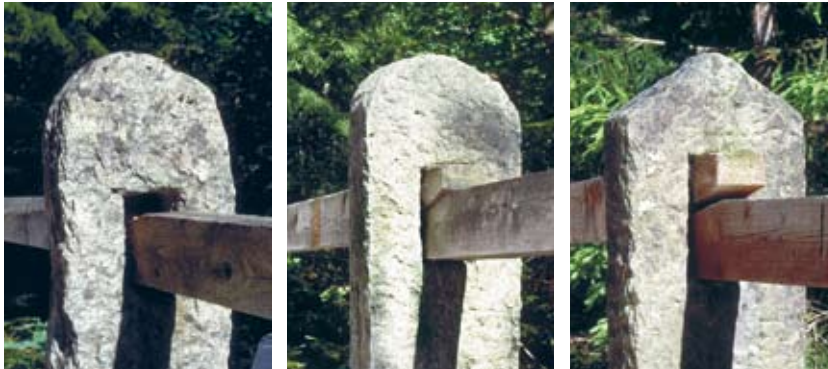
Details wie den verschieden geformten Köpfen von Steinpfosten ist bei Nachbildungen besondere Beachtung zu schenken (ViaStoria/Arne Hegland).
