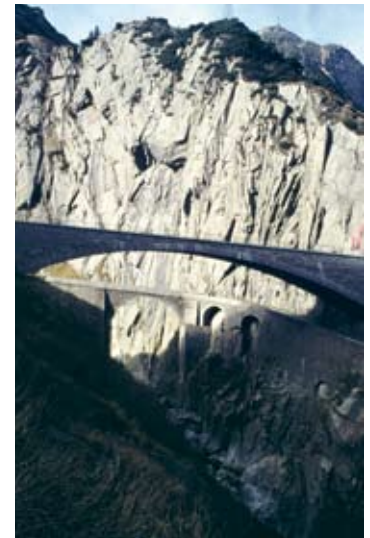
Entlastung durch Neubau: Die «Teufelsbrücke» der Gotthardstrasse von 1830 war dem Autoverkehr nicht gewachsen und wurde 1955/56 durch eine neue Strassenbrücke entlastet. Schöllenschlucht UR (ViaStoria/Cornel Doswald).
