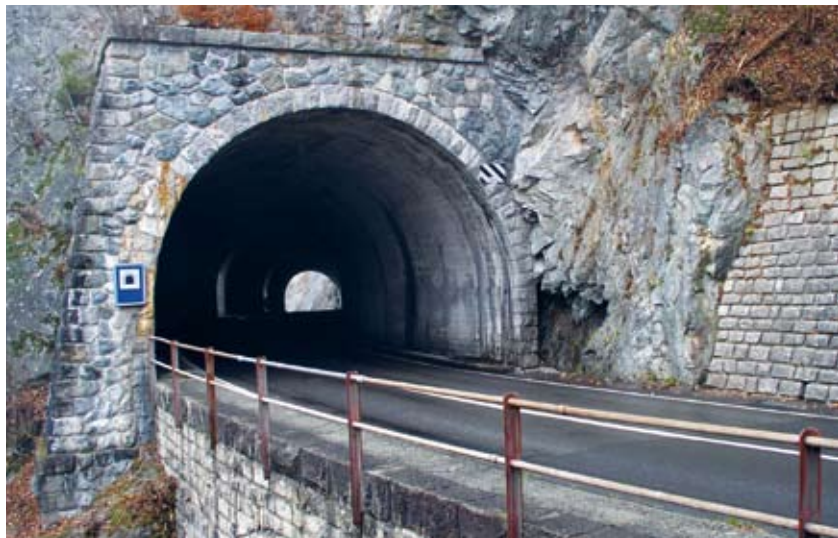
Originaler Bauzustand: Ostportal des 1940 erstellten Wylertunnels an der Sustenpassstrasse (Gde. Innertkirchen BE) vor der Erneuerung (ViaStoria/Guy Schneider).
