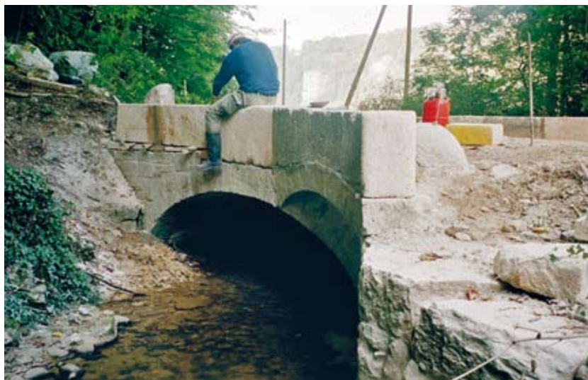
Restaurierung: Die Brücke über den Homburgerbach bei Läfelfingen BL, eine Strassenbrücke von 1810, wurde 2002 restauriert, wobei die Quader der Brüstungsmauern neu versetzt und einzelne Steine ausgewechselt wurden. Sie gehört heute zu einer Güterstrasse, die auch als Radweg signalisiert ist (ViaStoria/Eneas Domeniconi).
