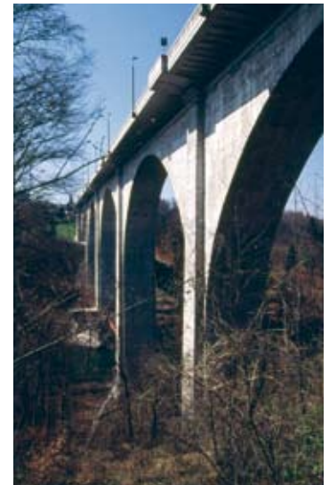
Durchgestaltete Verbreiterung: Die auskragende Fahrbahnplatte des Péroles-Viadukts in Freiburg FR mit Konsolen und Brüstungen wurde samt zeitgenössischer Brückenskapelle neu entworfen (ViaStoria/Cornel Doswald).
