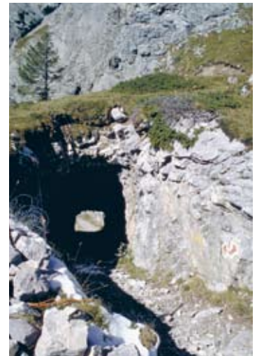
Der Ausbruch dieses einfachen, nicht ausgekleideten Tunneln in kristallinem Fels geht auf eine Erneuerung des Rawil-Saumpfades auf der Walliser Seite im 19. Jahrhundert zurück (ViaStoria/Vanessa Bitz).
