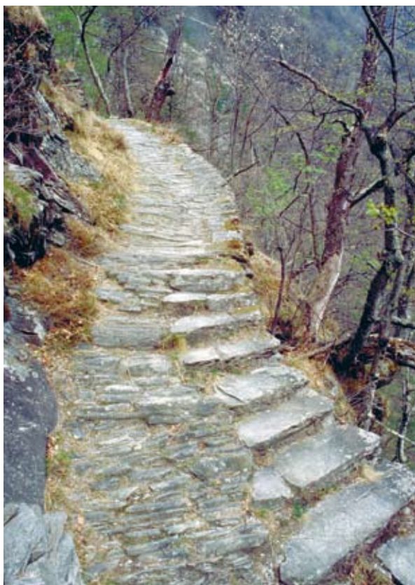
Aufwändig gebauter Saumweg in einer Steilstufe: Er besitzt ein Reihengestell mit hochkant gestellten Platten und Trittstufen aus Steinplatten. Zwischen Promontogno und Soglio GR (ViaStoria/Guy Schneider).
