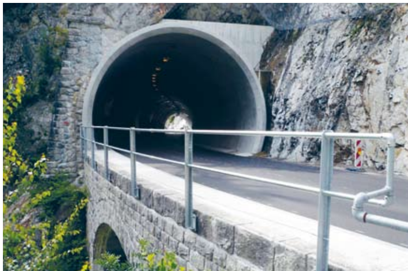
Erneuerung durch zeitgenössische Mittel: Ostportal des 1940 erstellten Wylertunnels an der Sustenpassstrasse nach der Erneuerung 2006/07 mit sorgfältig durchgestaltetem kreisförmigem Betongewölbe und Restbestand des ursprünglichen Portals (ViaStoria/Guy Schneider).
