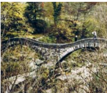
Teilrekonstruktion: Die Verzascabrücke in Lavertezzo TI ist ein gutes Beispiel für die handwerklich perfekt ausgeführte Rekonstruktion eines eingestürzten Brückenbogens. Als Vorbild für den in den 1950er-Jahren ergänzten Bogen diente das ältere, erhalten gebliebene Gewölbe (ViaStoria/Arne Hegland).
