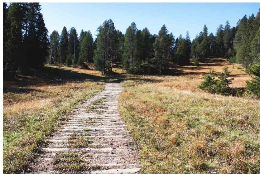
Mit Prügeln befestigte Wegoberfläche des Alten Schwyzerwegs bei Oberiberg (SZ).
