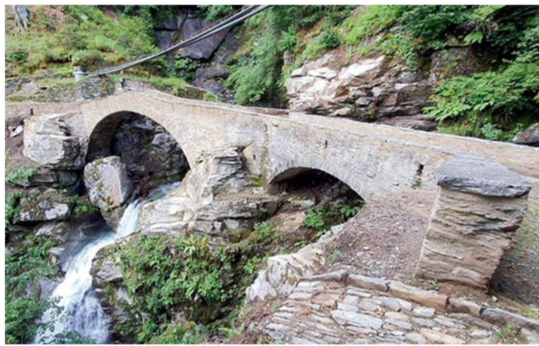
Die instandgesetzte Ponte Faidàl mit dem original erhaltenen Steinbogen (links) aus dem 17. Jahrhundert. (Foto: Lucchini – Mariotta e Associati SA)
