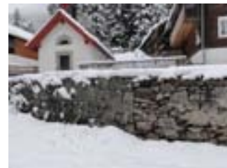
Das rechte Mauersegment wurde in klassischer Trockenbauweise Instand gestellt. Das linke Segment wurde dagegen gemörtelt. Foto: Fredi Bieri für das Bundesamt für Strassen ASTRA.
