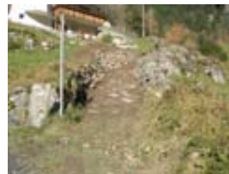
Der alte Sustenweg nach der Instandstellung. Foto: Theiler Landschaft GmbH.
