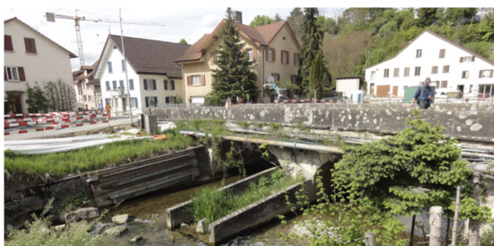
Ill. 7 : Travaux de construction au pont Surbrücke à Döttingen (AG) (photo : S. Zala, Basler & Hofmann)
