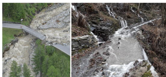
Hüscherbachbrücke, Splügen, Grisons / Route des Dilligences, Vernayaz, VS
