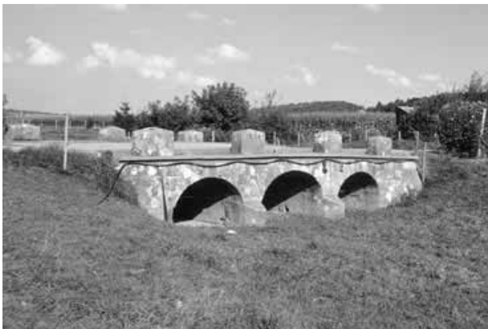
Fig. 1 : Ce pont au sud de Courtedoux fut érigé par dessus le ruisseau du Creugenat transformé et maîtrisé aujourd'hui en déversoir occasionnel.
