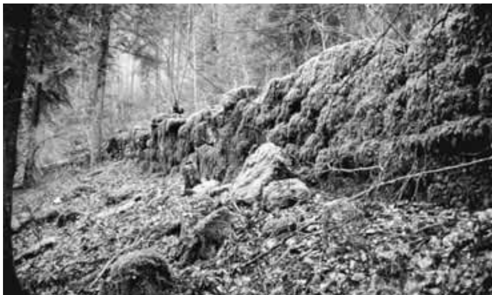
Fig. 5 : A peine visible depuis la voie, ce long mur de soutènement couvert de mousse est en bon état de conservation.
