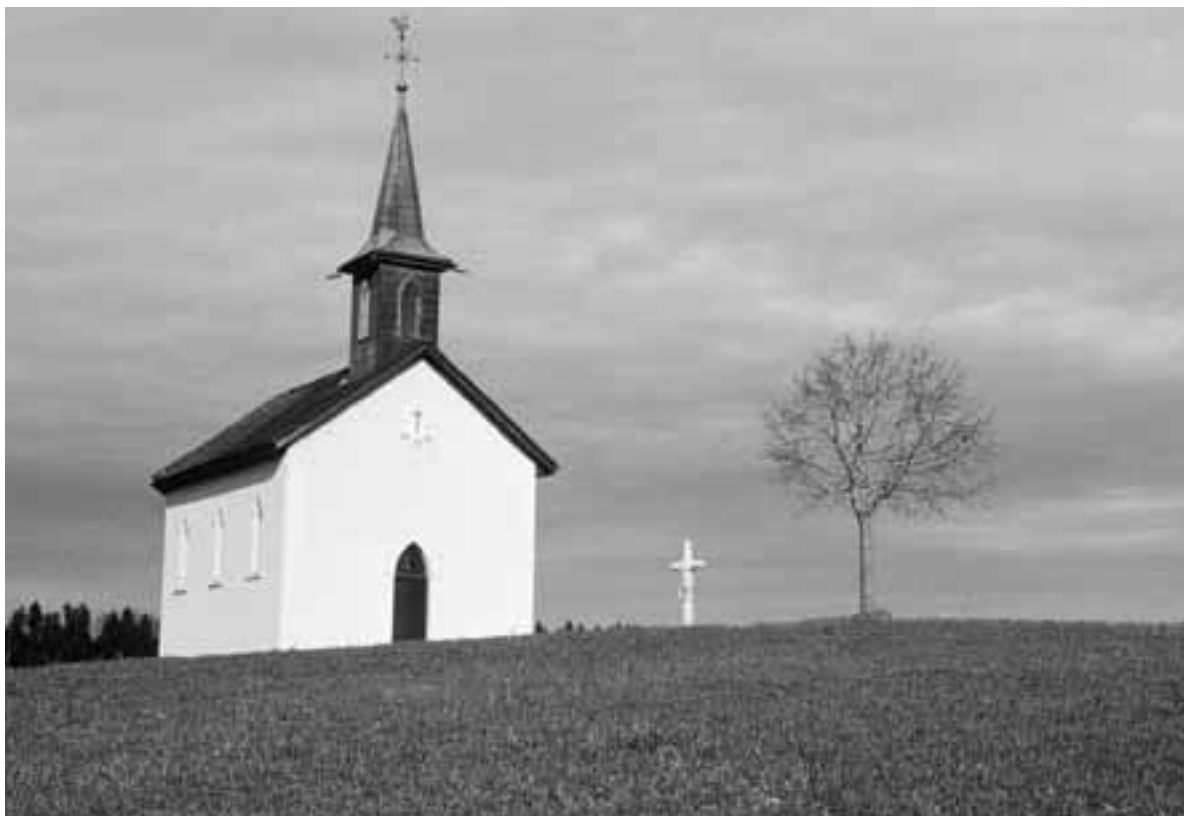
Fig. 4: Chapelle à La Bosse placée sous la protection de la Confédération depuis 1975. Située au carrefour de deux chemins historiques encore en usage, l'édifice est un puissant marqueur paysager.
