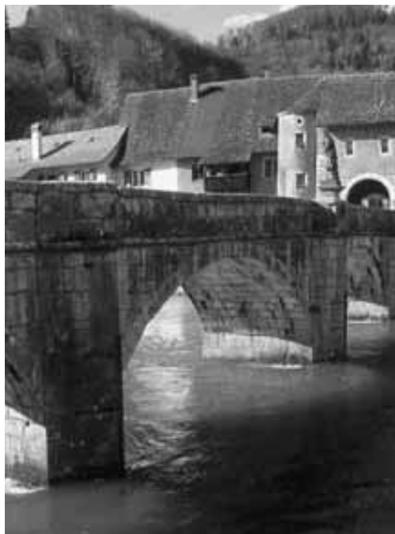
Fig. 2 : De puissants becs protègent les piles du pont de la force de l'eau et de la glace hivernale. Depuis 1731, la Statue de Saint-Jean Népomucène marque le milieu du pont.
