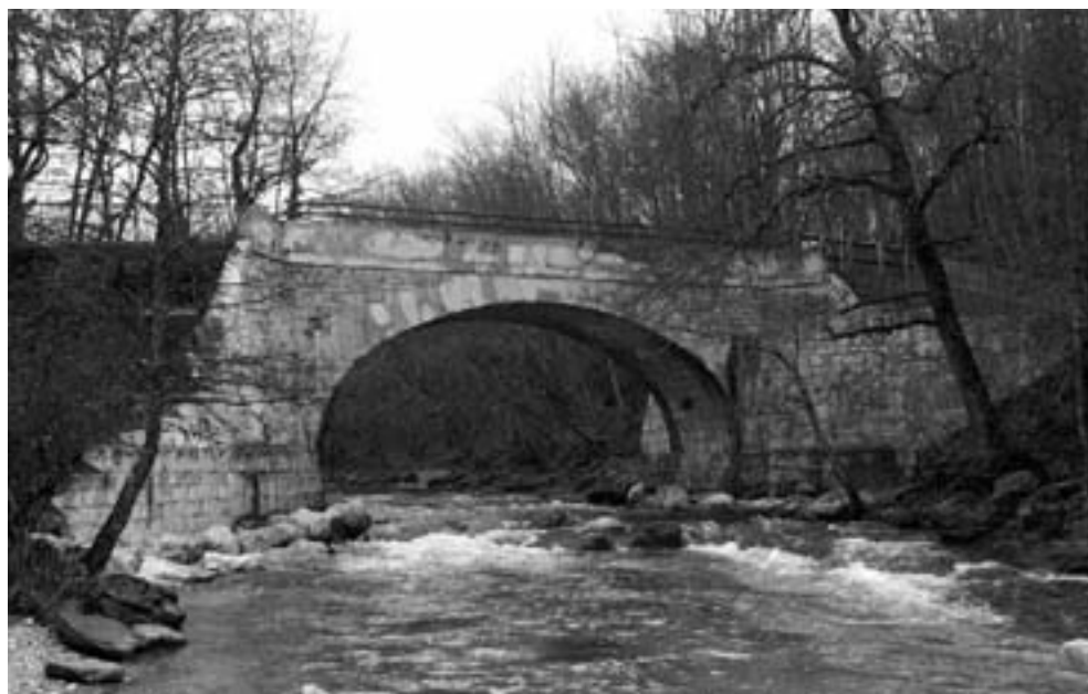
Le pont des Granges sur l'Allondon, daté de 1842 (GE 400.0.6).
