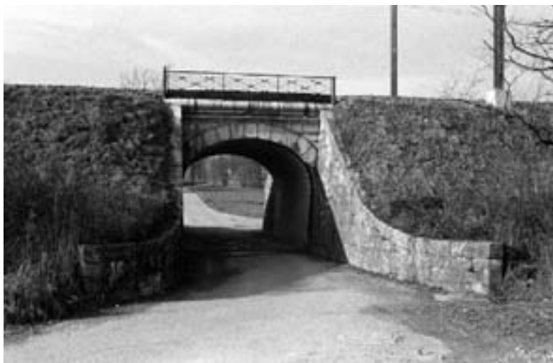
La superposition du réseau ferré au réseau routier a donné naissance à de délicieux aménagements. Ici, à La Plaine, un petit passage sous voie aux lignes arrondies réalisé en appareil de pierre blanche.
