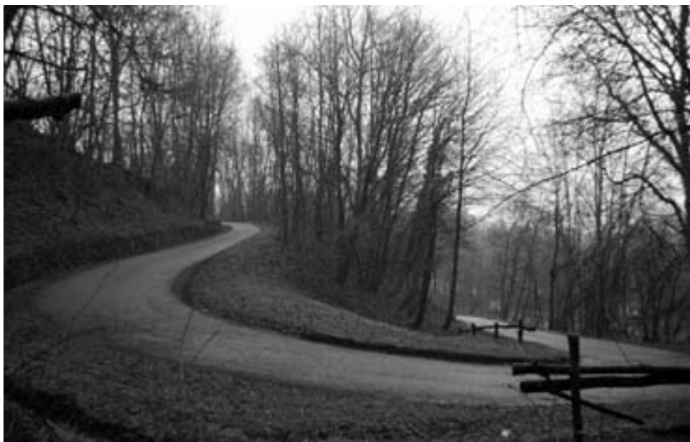
Les courbes réglées, un apport du XIX ème siècle. Ici l'épingle du chemin du Jectus (GE 401.0.6), remontant depuis le val de l'Allondon vers Essertines, remplace un ancien tracé plus direct (GE 401.0.7).
