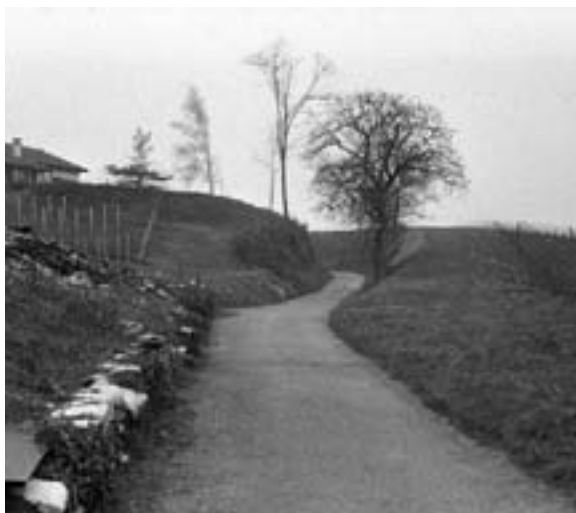
Peissy, la Vy Creuse: à l'entrée inférieure du chemin, un mur de pierre à couronne plate se prolonge jusqu'au cimetière et soutient de ses deux mètres de hauteur le talus de gauche. En face le talus naturel est en partie laissé à la végétation.
