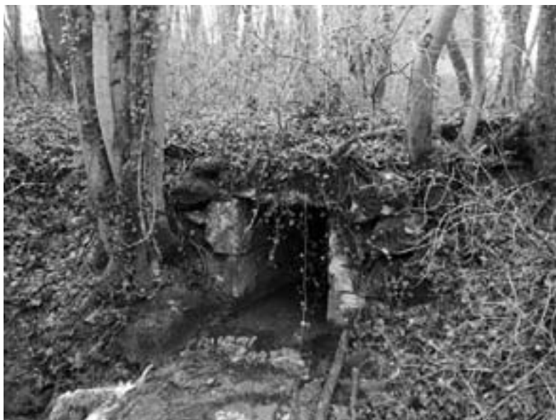
Ponceau sur le ruisseau des Palatières (GE 401.0.9).
