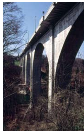
Elargissement bien maîtrisé: la plateforme de roulement en surplomb du viaduc de Pérolles à Fribourg FR, avec consoles et mur de parapet, est de conception nouvelle, tout comme la chapelle contemporaine (ViaStoria/Cornel Doswald).
