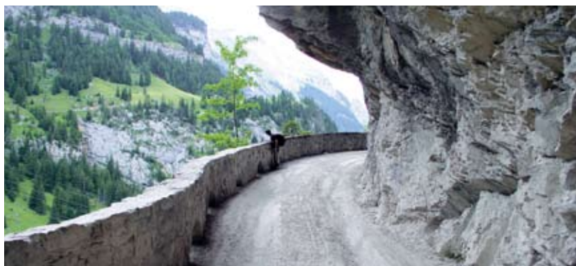
Cette semi-galerie recouvre la route sur presque toute sa largeur. Gasterenstrasse, Kandersteg BE (ViaStoria/Guy Schneider).
