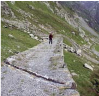
Traverse en pierre, enfoncée dans le chemin, qui reste ainsi carrossable. Ancienne route du col du Susten UR (ViaStoria/Guy Schneider).
