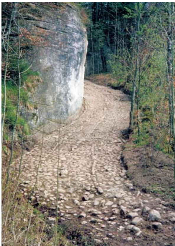
Pavage en galets de rivière de type «têtes-de-chat», avec bandes de roulement séparées par des rangées de pierres. Au bord de la Sarine, près de Heitenried FR (ViaStoria/Fredi Bieri).
