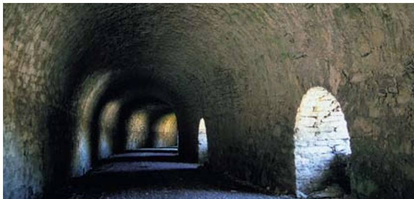
Exemple rare d'une galerie pare-avalanches historique du XIX e siècle: voûte en berceau faite de rangées de moellons, fenêtres en plein cintre appareillées en pierres de taille. Col du Splügen GR (ViaStoria/Arne Hegland).
