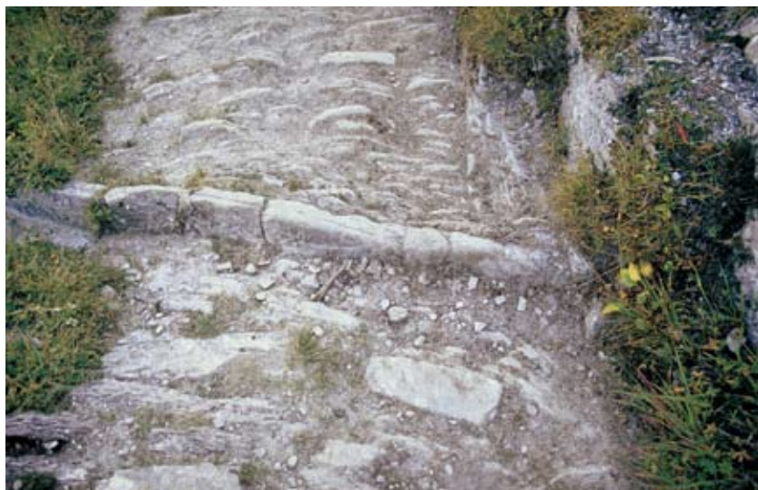
Traverse faite de dalles dressées, sur le chemin d'alpage non carrossable allant de Bargis GR au Flimserstein (ViaStoria/Arne Hegland).
