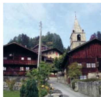
A Gryon VD, les murs constituent les limites de l'espace public et accentuent la structuration du noyau villageois par les rues, les bâtiments et les jardins adjacents (ViaStoria/Andriu Maissen).
