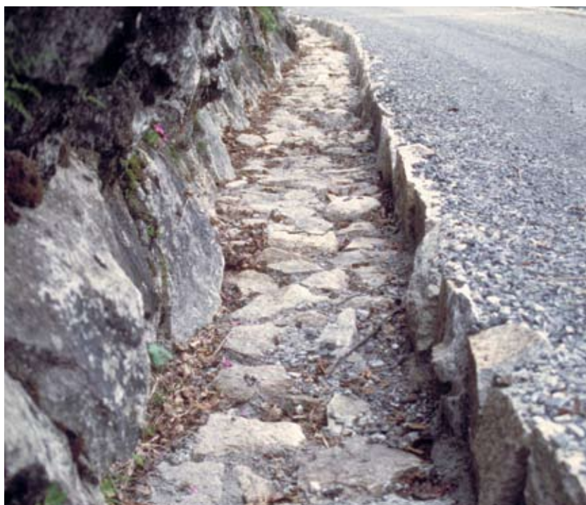
Fossé en moellons sur lit de pierres, d'exécution artisanale. Ancienne route du Gothard, aux Schöllenen UR (ViaStoria/Arne Hegland).
