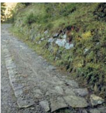
Voie charretière pour charrettes, pavée, élargie et empierrée pour permettre le passage des chars. Alpnach OW (ViaStoria/Guy Schneider).
