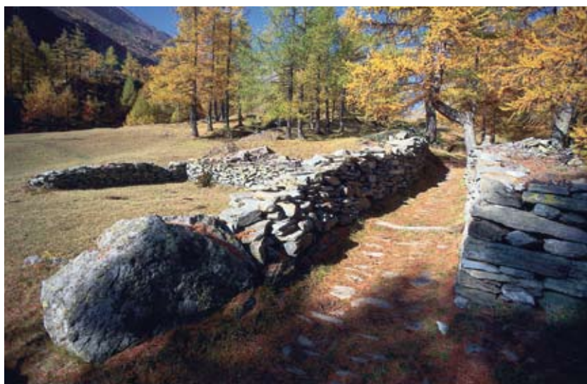
Le chemin Stockalper, chemin muletier du XVII e siècle, à Engi au sud du col du Simplon VS. Sa largeur et sa configuration sont adaptées au portage des marchandises par des bêtes de somme, alors largement répandu, et correspondent aux moyens techniques de l'époque en matière de construction routière (ViaStoria/Heinz Dieter Finck).
