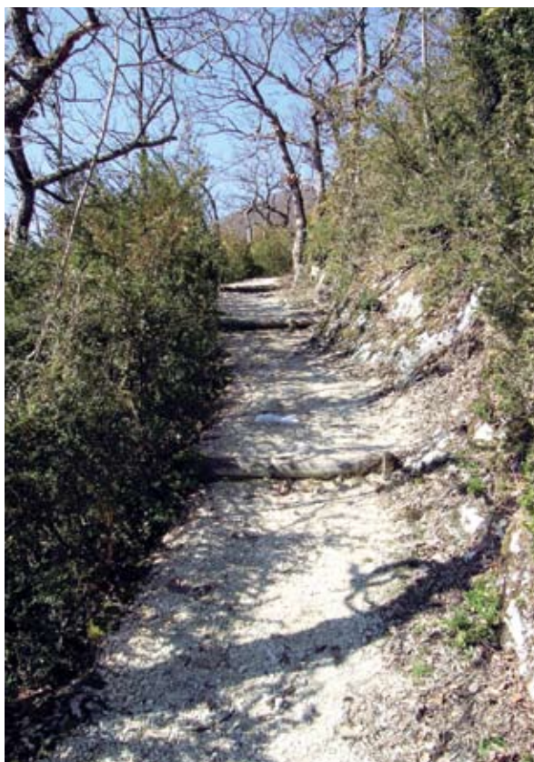
Empierrement: exemple caractéristique de chemin de randonnée pédestre touristique avec empierrement en calcaire du Jura, sur un terrain rocheux en pente. La «Jakobsleiter» près d'Egerkingen SO (ViaStoria/Cornel Doswald). Voir p. 54.
