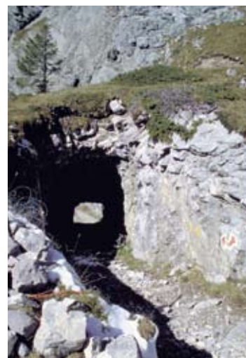
Le percement de ce tunnel tout simple, sans revêtement, dans la roche cristalline remonte à une réfection du sentier muletier du Rawyl, sur son versant valaisan, au XIX e siècle (ViaStoria/Vanessa Bitz).
