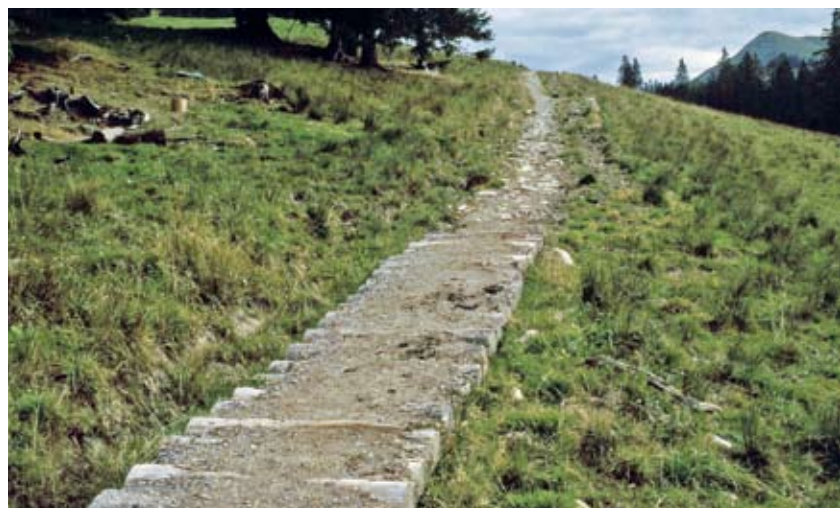
Un chemin de rondins recouvert de gravier, segment d'un chemin pédestre traversant une pente marécageuse. Au Schwendeli près de Glaubenbielen OW, sur le chemin menant à Sörenberg LU (ViaStoria/Arne Hegland). Voir p. 63.
