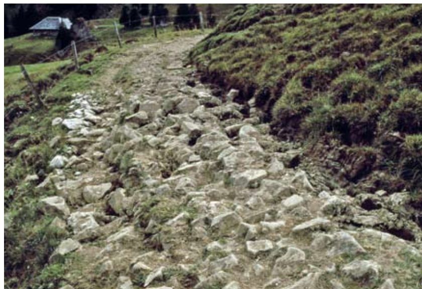
Cette voie charretière empierrée est pourvue, pour la traversée d'une zone humide, d'un lit de pierres grossières. Nūnalp, Giswil OW (ViaStoria/Arne Hegland).
