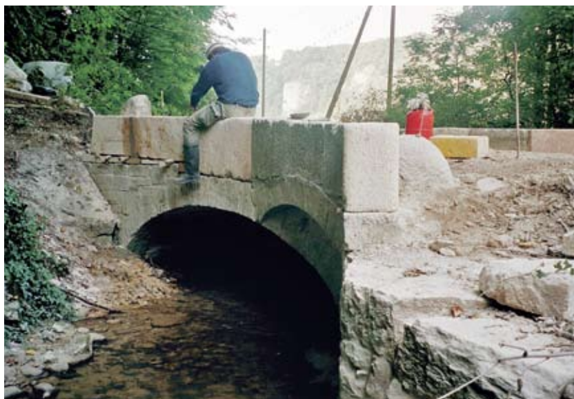
Restauration: le pont sur le Homburgerbach près de Läufelfingen BL, construit en 1810, a été restauré en 2002; on a rénové les blocs des parapets et remplacé des pierres. L'ouvrage fait aujourd'hui partie d'une route agricole, également signalisée comme piste cyclable (ViaStoria/Eneas Domeniconi).
