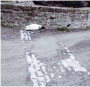
Coque pavée sur une chaussée alpestre évacuant directement les eaux par une fenêtre pratiquée dans le parapet. Le dispositif doit être périodiquement débarrassé du gravier qui s'y accumule, en provenance de la surface de la route (ViaStoria/Arne Hegland).
