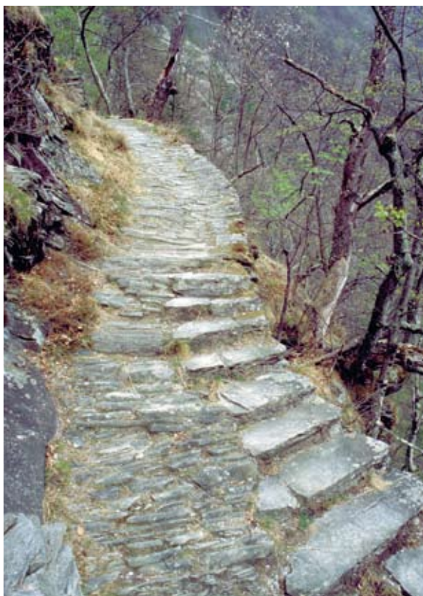
Chemin muletier aménagé avec soin dans un passage particulièrement raide, possédant un pavage fait de rangées de plaques posées de champs et un escalier dallé. Entre Promontogno et Soglio GR (ViaStoria/Guy Schneider).
