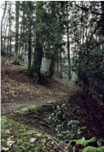
Chemin pédestre non consolidé, modelé dans le sol naturel tendre d'une pente. A l'est de l'Egelsee près de Bergdietikon AG (ViaStoria/Cornel Doswald).
