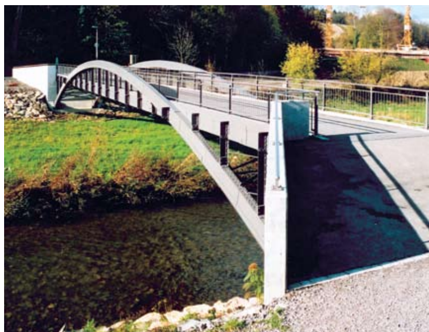
Déplacement: la «Höcklerbrücke», lancée sur la Sihl à Zurich-Leimbach en 1866, a été détachée de ses piles en 1998/1999, déposée à terre pour réhabilitation, puis replacée en amont sur de nouvelles piles. Dans l'opération, le pont a été réduit à sa structure porteuse, une arche non auto-porteuse, et doté de nouvelles piles et d'un nouveau tablier. Il est aujourd'hui intégré au réseau de mobilité douce (Basler & Hofmann/Michael Ruf).
