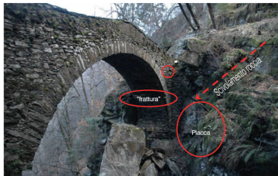
Un relevé rigoureux des dégâts était une condition indispensable pour mener à bien la remise en état. (Foto: Lucchini – Mariotta e Associati SA)
