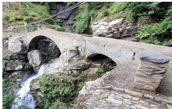
Le Ponte Faidàl remis en état : son arc original en pierre (gauche) datant du 17 e siècle a été conservé. (Foto: Lucchini – Mariotta e Associati SA)
