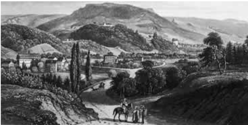
Abb. 12 (oben): Die Münchensteinerstrasse und die im Vordergrund von links nach rechts durch das Bild verlaufende Birstalstrasse präsentierten sich auf der Höhe der «Neuen Welt» um die Mitte des 18. Jahrhunderts noch als gewundene, von Fahrspuren durchfurchte, erdige Wegbänder von wechselnder Breite, wie die Darstellung von Emanuel Büchel zeigt.
