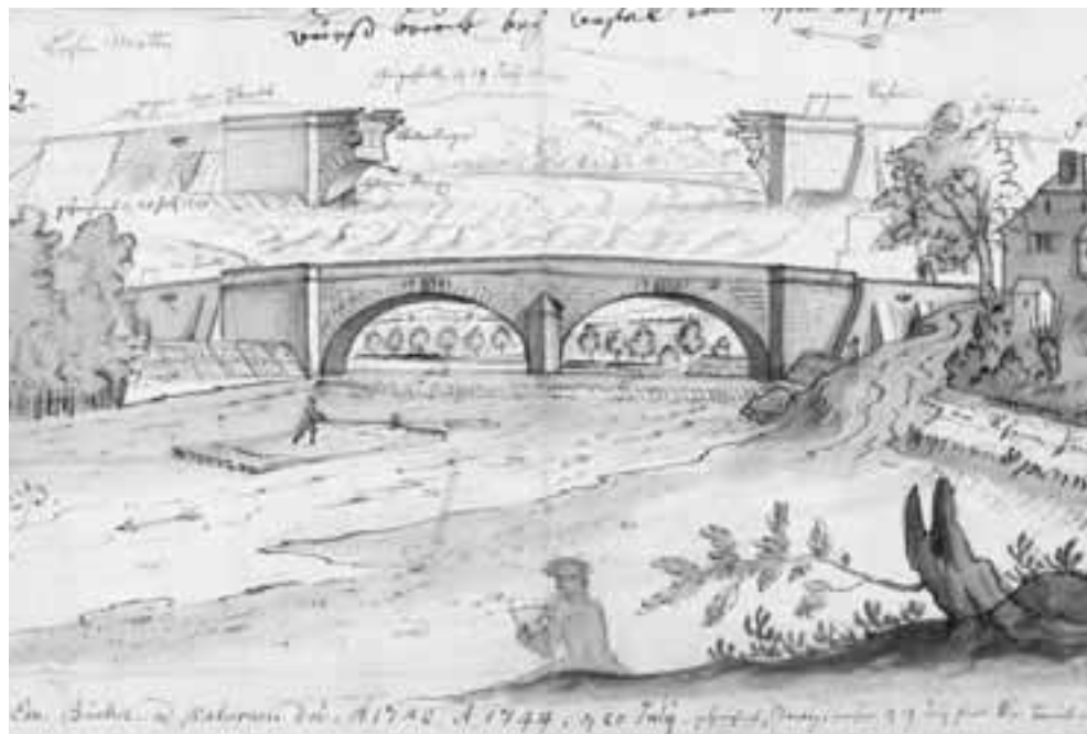
Abb. 3: Die 1741 fertig gestellte Birsbrücke von Birsfelden war die grösste Mauerwerksbrücke des Kantons. Lang gestreckte Zufahrtsdämme verringerten die Zahl und Spannweite der Öffnungen, schnürten aber auch das Flussbett ein. Aus Kostengründen wurde die Brücke ungenügend fundiert und brach bereits 1744 in einem Hochwasser zusammen. Emanuel Büchel hat ihre Geschichte in seinen Zeichnungen vielfältig dokumentiert (Staatsarchiv Basel-Stadt, Bilderslg. Falk. Fb 3,2).
