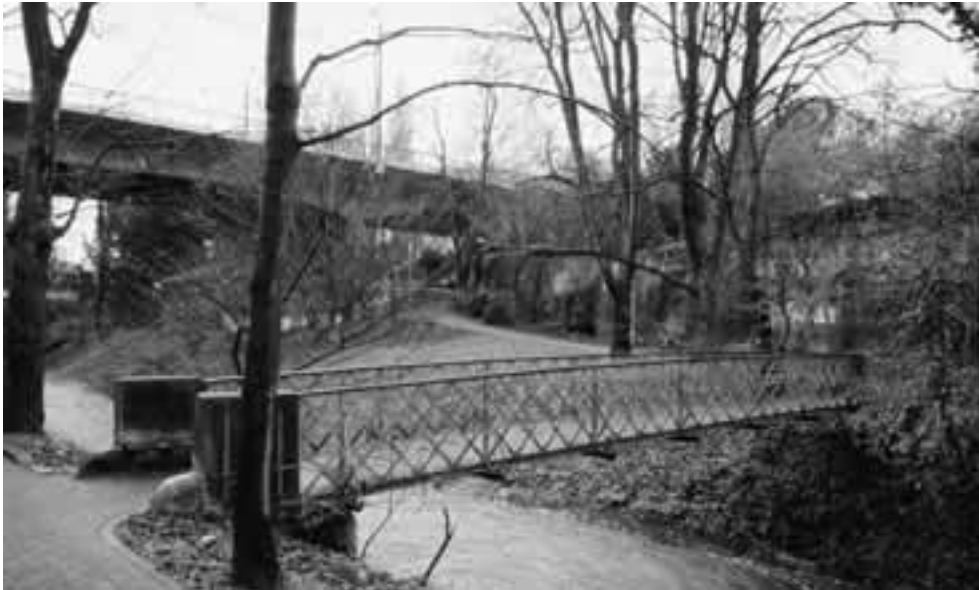
Abb. 12 (oben): Der Stahlgittersteg im Birsigtal unterhalb des Dorenbachviadukts in Basel ist mit seinen Gittertragwerken aus flachen Walzeisen eine selten gewordene Konstruktion. Mit dem Baujahr 1865 ist er einer der ältesten bestehenden Stahlstege der Schweiz (CD).
