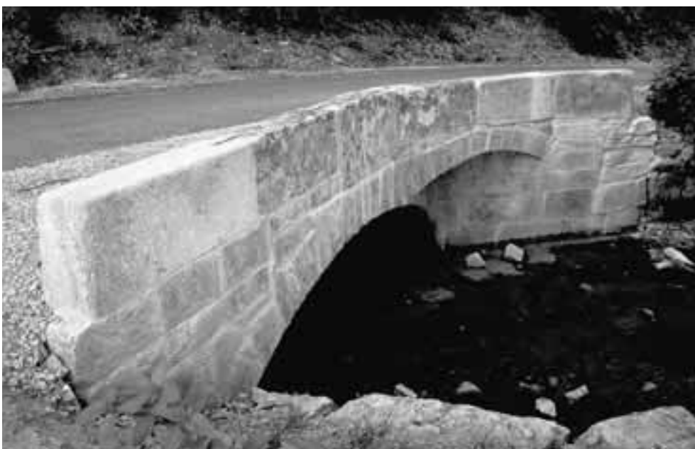
Abb. 8: Die Details der Gewölbekonstruktion der Brücke über den Homburgerbach bei Läfelfingen treten nach der sorgfältig ausgeführten Renovation im Jahr 2002 wieder deutlich hervor (ED).
