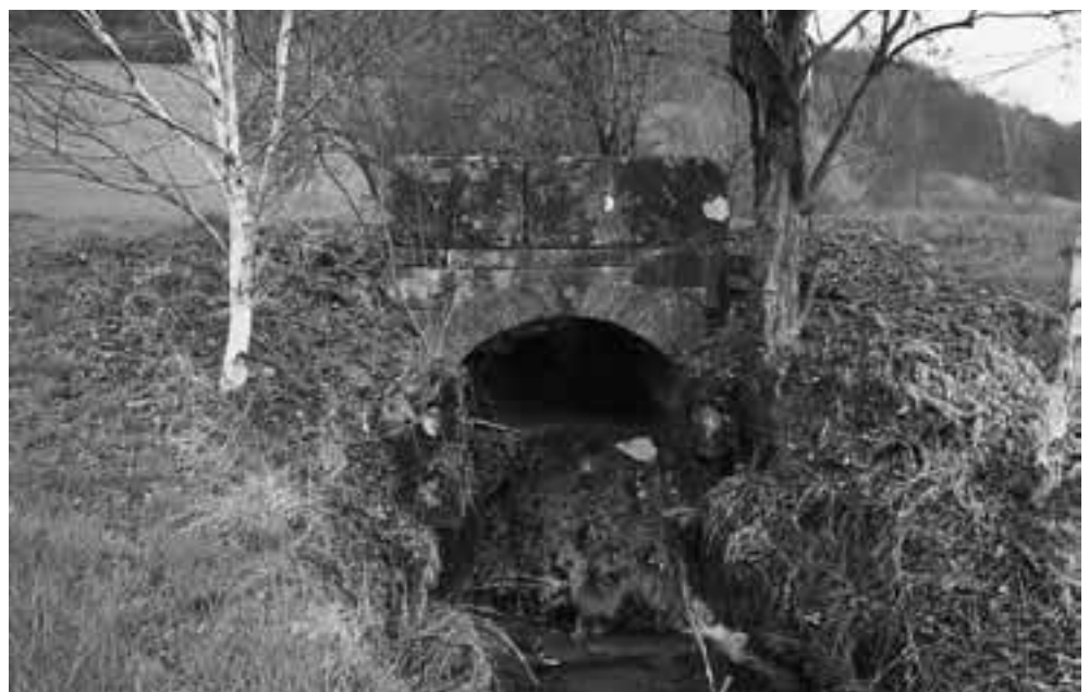
Abb. 6: Das «Joggi-Mohler-Brüggli» südlich von Tenniken ist eine typische kleine Kunststrassenbrücke aus Quadermauerwerk, wie sie im Zug des Ausbaus der Talstrassen entstanden. Es wurde kurz nach 1826 als Teil der Strasse durch das Diegtertal erbaut (ED).
