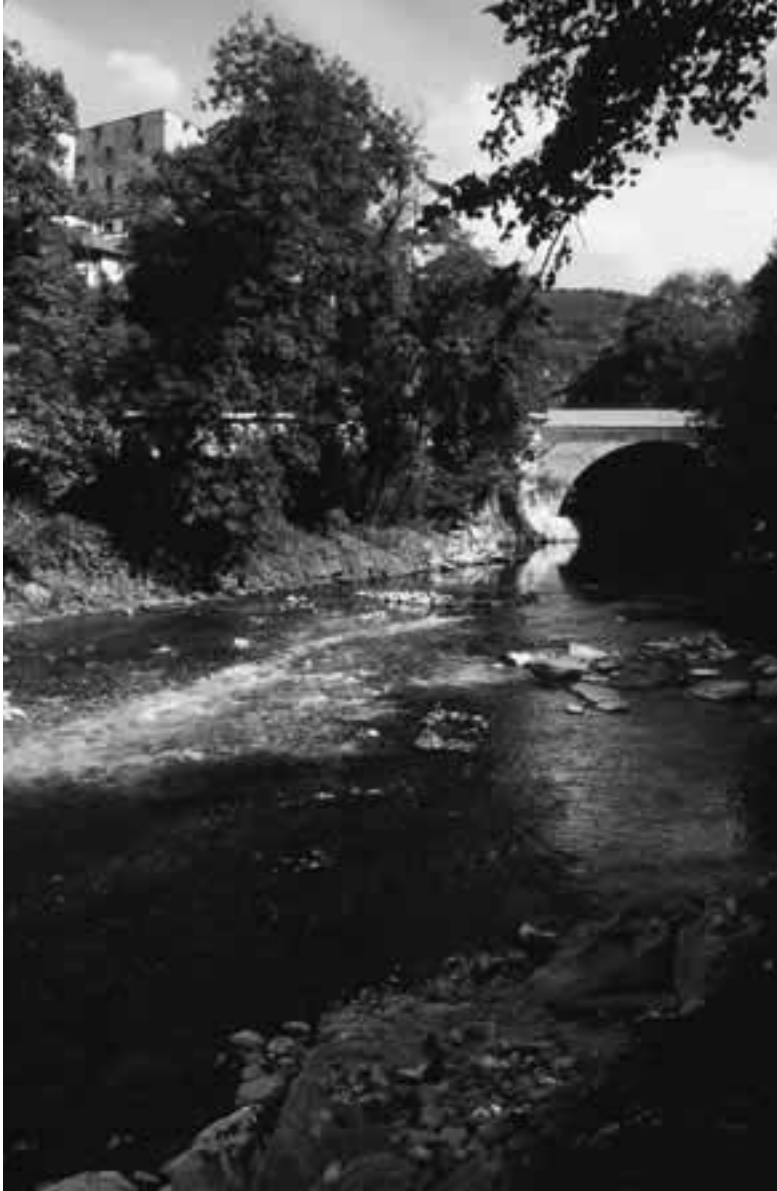
Abb. 5: Die Birsbrücke Angenstein erscheint nach der Sanierung wieder als die architektonisch angemessene Ergänzung des Schlosses, das hoch über dem engen Birsdurchbruch aufragt (CD).
