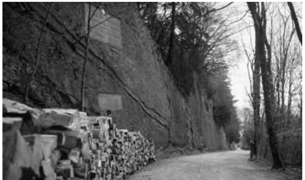
Abb. 1: Einer der interessantesten Abschnitte der Belchensüdstrasse mit extrem steiler Felsböschung liegt ganz im Westen, unterhalb der Belchenfluh. Die grosse Inschrift erinnert an den Bau der Strasse von November 1914 bis August 1915 (RB).
