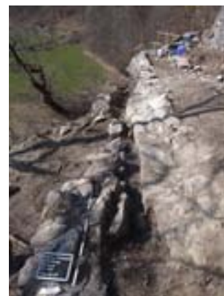
Le relevé archéologique est une préparation à la reconstruction : fondements anciens (à droite) et plus récents d'un mur de parapet sur la partie supérieure de la paroi rocheuse. (Maja Widmer 2011)
