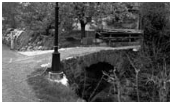
Abb. 31 (rechts oben): Die Steinbogenbrücke von Rüti über die Linth (GL 220.0.1). Der Mittelpfeiler wird bergseitig von einem Wellenbrecher gegen die Fluten geschützt (Andriu Maissen 8.6.03).
