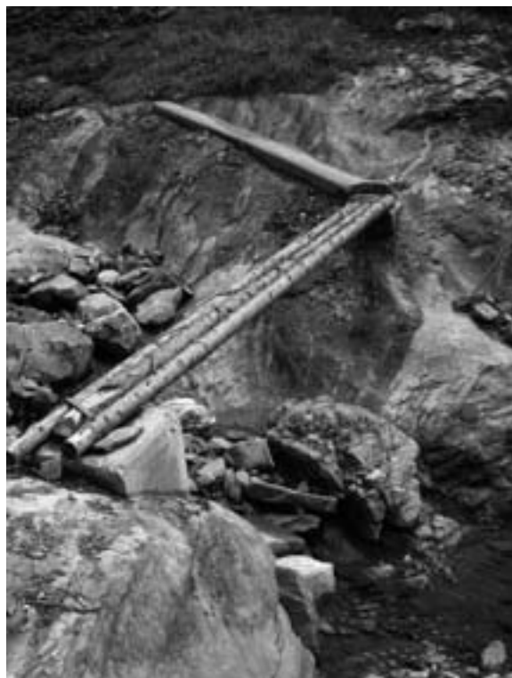
Abb. 26: Einfachste Bauweise einer Brücke: Steg über den Furbach (GL 204.2; Christine Doerfel 22.9.05).
