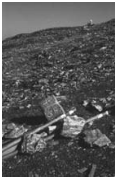
Abb. 11 (oben): Randplatten als Abstützung bei einem einfachen Hangweg unterhalb Obbort bei Tierfed (ohne IVS-Nr.; Christine Doerfel 22.9.05).
