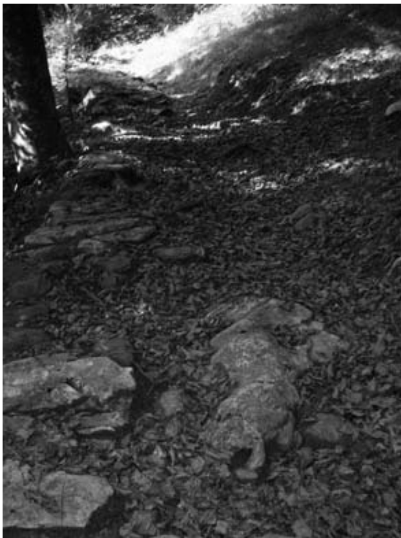
Abb. 11 (oben): Randplatten als Abstützung bei einem einfachen Hangweg unterhalb Obbort bei Tierfed (ohne IVS-Nr.; Christine Doerfel 22.9.05).
