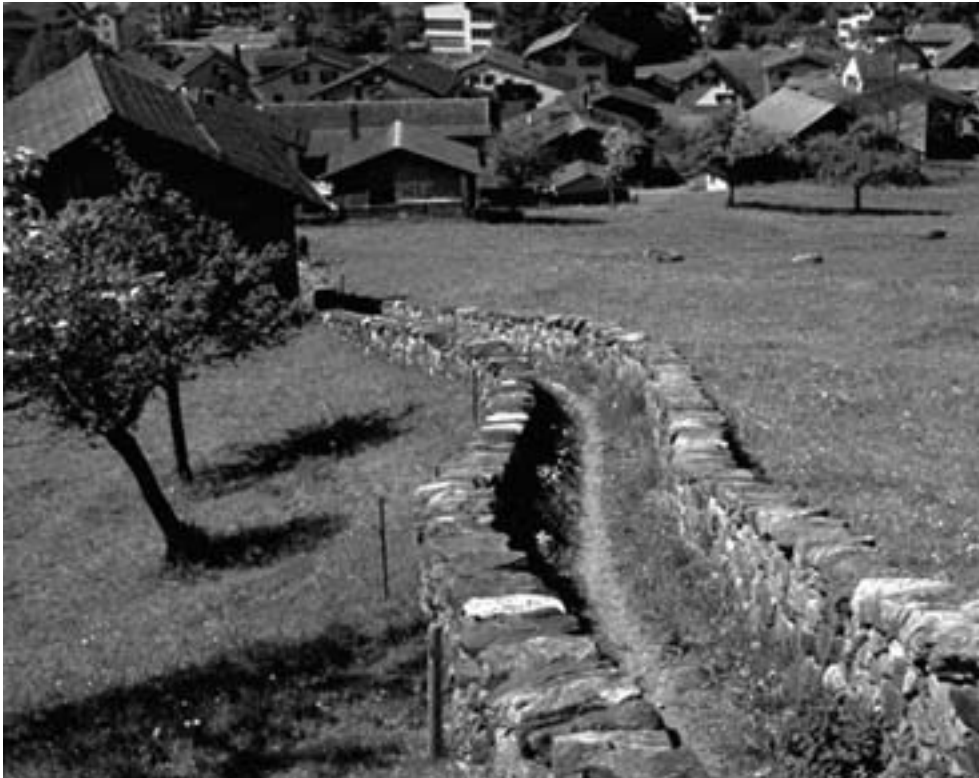
Abb. 12 (linke Seite oben): Gassen können auch durch einen Zaun und eine Trockenmauer gebildet werden, wie hier die Gasse in Grund, Engi-Dörfli (GL 263.0.1; Christine Doerfel 8.9.05).
