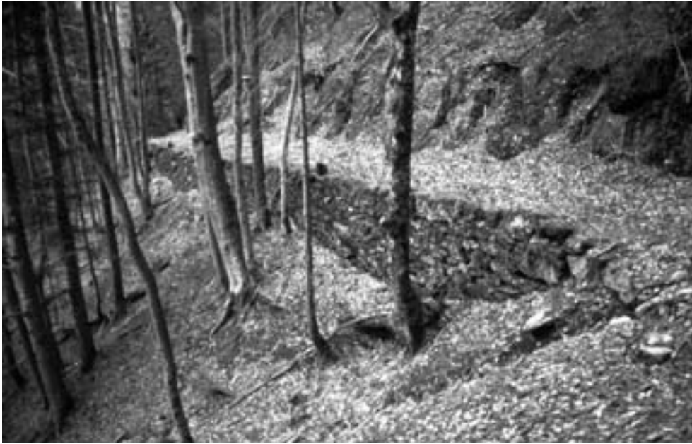
Abb. 2: Blick auf die «Alte Fruttegstrasse» im Fruttegwald. Der 2.2 m breite Weg weist hier Stützmauern von 1–2 m Höhe auf. Ankersteine stabilisieren die Böschungen. Gemäss der Beschreibung ihres Erbauers, des Ingenieurs Trucco, war sie mit einem hölzernen Lattenzaun gesichert und mit Wasserabzügen versehen. Noch in den 1950er-Jahren wurde sie befahren, genügte aber den Anforderungen des motorisierten Verkehrs nicht mehr.
