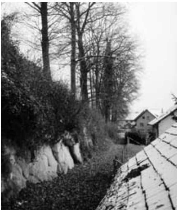
Abb. 3: Die Seesatzgass ist 350 Jahre nach Wägmanns Plan (Abb. 2) noch immer eindrücklich erhalten. Seit sie nach der Seeabsenkung im Jahre 1806 zugunsten einer neuen Strassenlinie aufgegeben wurde, dient sie nur noch dem lokalen Fussverkehr. Noch heute ist sie – zumindest bergseitig – von einer markanten Eichenhecke und einer Felsböschung begleitet.
