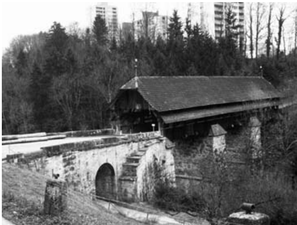
Abb. 5: Die Rothenburger Brücke von 1714–1717 ist eine der beiden Holzbrücken der Landstrassenzeit im Kanton Luzern, die bis heute überlebt haben. Die 7.5 m breite Fahrbahn mit Sprengwerk liegt 21 m über der Talsohle; sie wird von zwei Brückenpfeilern gestützt.
