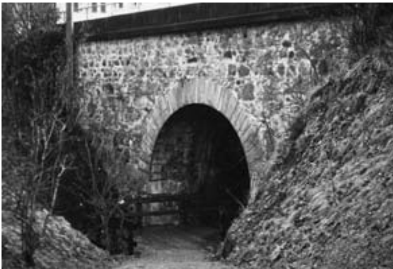
Abb. 4 und 5: Die alte und die neue Suhrebrücke im heutigen Zustand. Die alte Brücke (oben), 1806 vom Luzerner Baumeister Niklaus Purtschert entworfen, ist als höchst schützenswert einzustufen.
