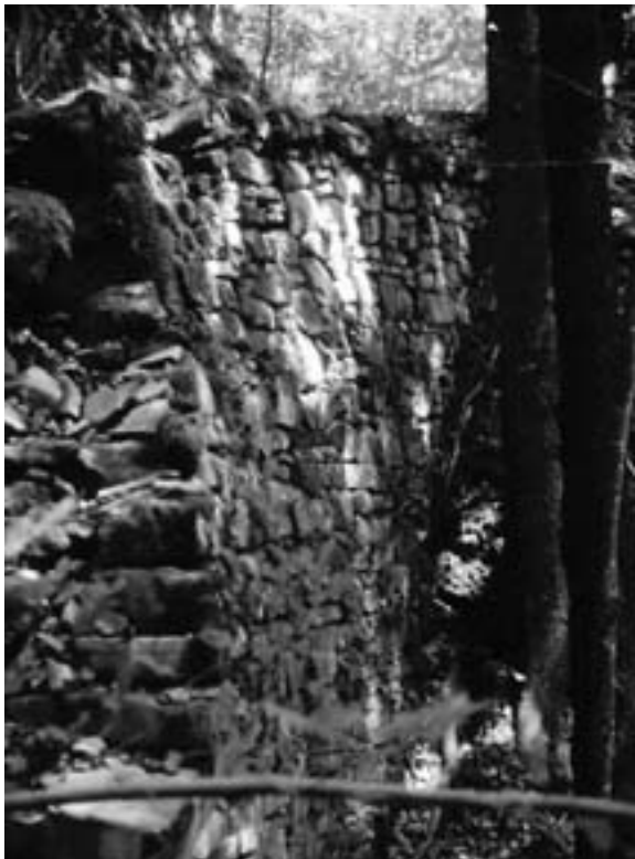
Abb. 3: «Sämtliche Mauern sind natürlich in zweckmässigster Dicke mit \frac{1}{10} Anzug [...] zu erstellen», hält der Ingenieur Trucco in der Beschreibung des Projekts von 1872 fest. Die Stützmauern sind bis 4 m hoch und sehr kunstvoll aufgebaut. Abklärungen durch Spezialisten im Trockenmauerbau der Stiftung Umwelt-Einsatz Schweiz (SUS) weisen auf die Dringlichkeit der Sanierung hin, um den weiteren Zerfall zu verhindern.
