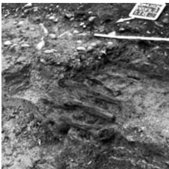
Abb. 4: Flickwerk an der wichtigsten Strasse des luzernischen Verkehrssystems: Eine Schwachstelle im Untergrund der Alten Baselstrasse im Rümlikewald wurde laufend mit Prügelagen aufgefüllt, so dass allmählich eine Gitterstruktur entstand.
