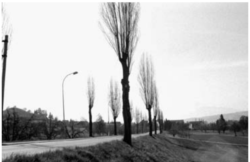
Abb. 11: Der eindruckliche, mit viel Aufwand erbaute Kunststrassendamm vor Hitzkirch ist 400 m lang und beidseitig mit Pappeln in gleichmässigen Abständen bestückt.
