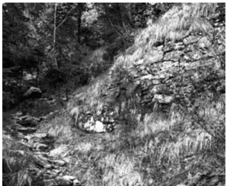
Abb. 3: Eine der Kehren des Bründlenwegs. Die Weganlage wurde 1735 in steilem Gelände errichtet und weist mehrere bauliche Elemente wie diese Trockenmauer auf.
