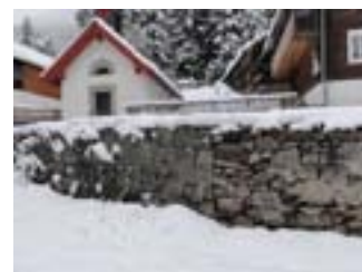
la partie droite du mur a été restaurée en technique traditionnelle de maçonnerie à sec, la partie gauche en maçonnerie liée. (Fredy Bieri pour l'Office fédéral des routes OFROU)
