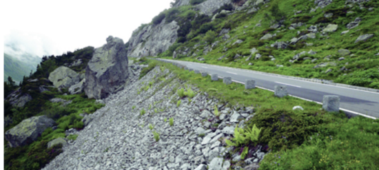
Immagine 5: Strada del passo del Susten con paracarri di pietra e ballast (Foto: G. Schneider)
