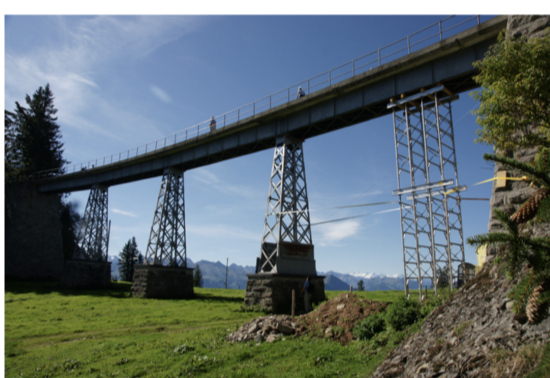
Immagine 4: Messa in sicurezza provvisoria del ponte a Unterstetten. Il ponte, assieme ai ponti di Rothenflue e Schild , crea un ensemble di ponti della ex linea ferroviaria Rigi Kaltbad–Unterstetten–Rigi . (Foto: F. Bieri, Basler & Hofmann)
