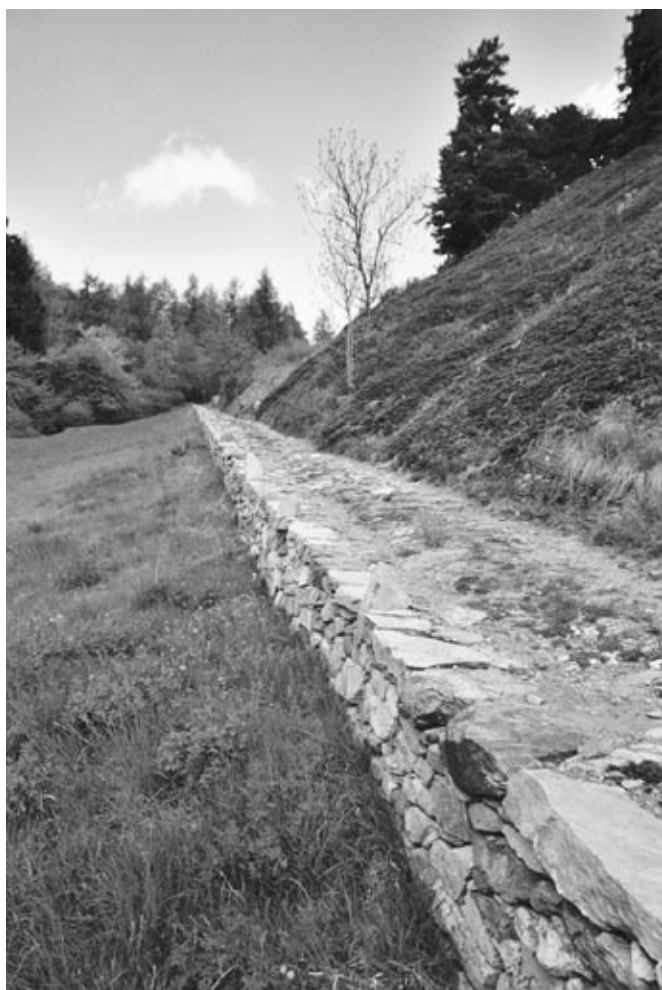
Fig.3 Aménagé selon la technique de construction des murs en pierre sèche, le sentier alpin près de Zeneggen (VS) Foto: M. Stromer, AGLG (2003)
