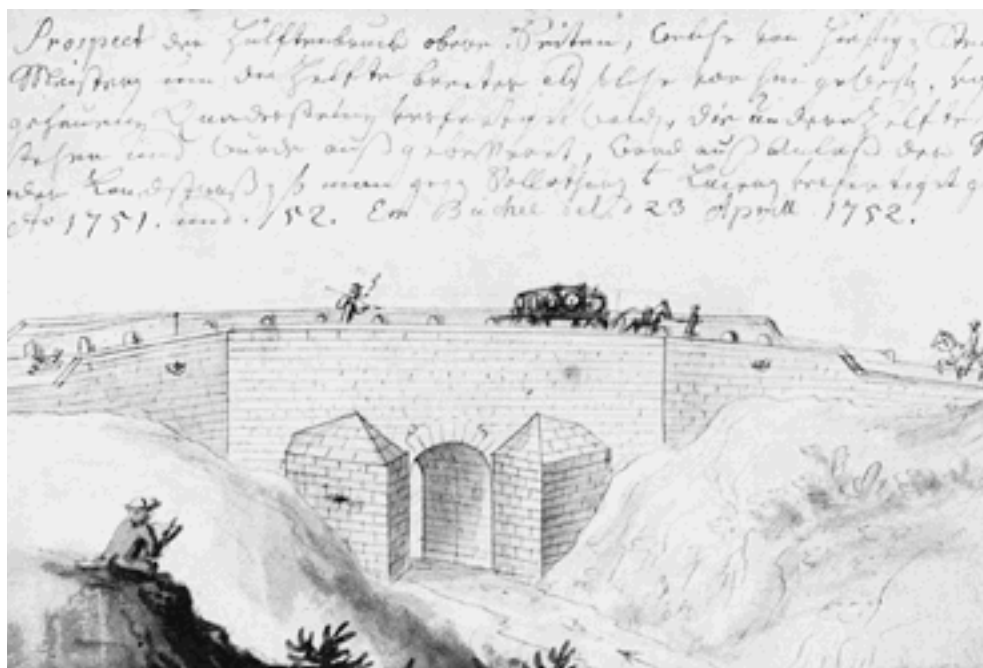
Abb. 4: Die Hülftenbrücke wurde 1751 aus Anlass des Ausbaus der Landstrassen nach Luzern und Solothurn ausgebessert und um die Hälfte verbreitert. Der Zeichner Emanuel Büchel hob in seinem Kommentar die «schön gehauenen Quadersteine» hervor, welche die Steinmetze verwendeten. Sie sind typisch für die repräsentativen Staatsstrassenbrücken des 18. und 19. Jahrhunderts (C. A. Müller: Baselbieter Bau- und Siedlungsgeschichte, Basel 1967, Abb. 6).
