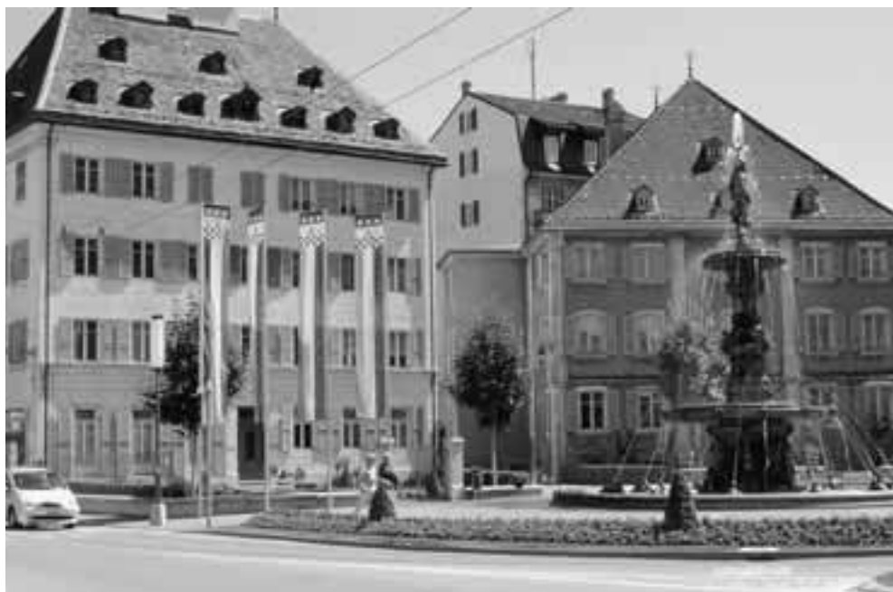
Ill. 8 (en haut) : La fontaine aux tortues a été érigée pour commémorer l'arrivée de l'eau courante de l'Areuse à La Chaux-de-Fonds, en 1887, un haut-fait technique qui constitue un des points forts de la modernisation de la ville.
