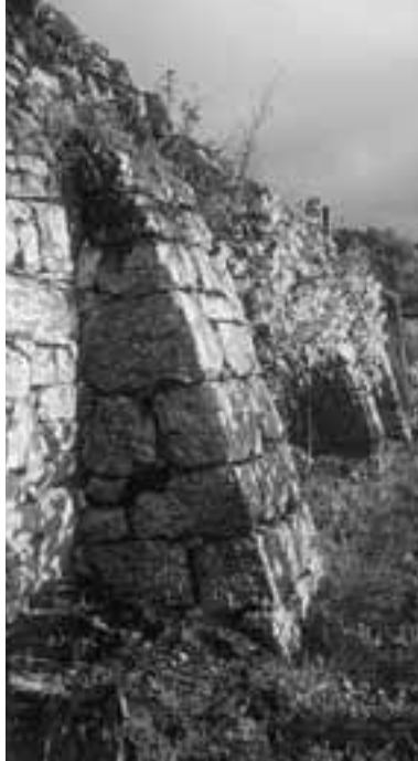
Ill. 2 : Imposant mur de soutènement renforcé entre le vignoble et la route villageoise de Cornaux à Cressier
