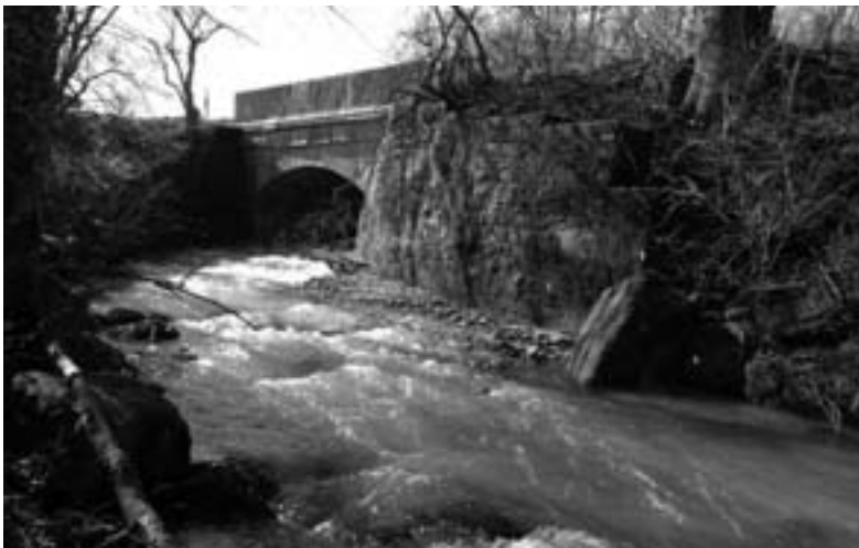
Abb. 10: Die Birsbrücke von Dornachbrugg, 1823. Obwohl sie heute zu tief im gestauten Wasser steht, erahnt man noch die Eleganz ihres Bogenpaares (CD).
