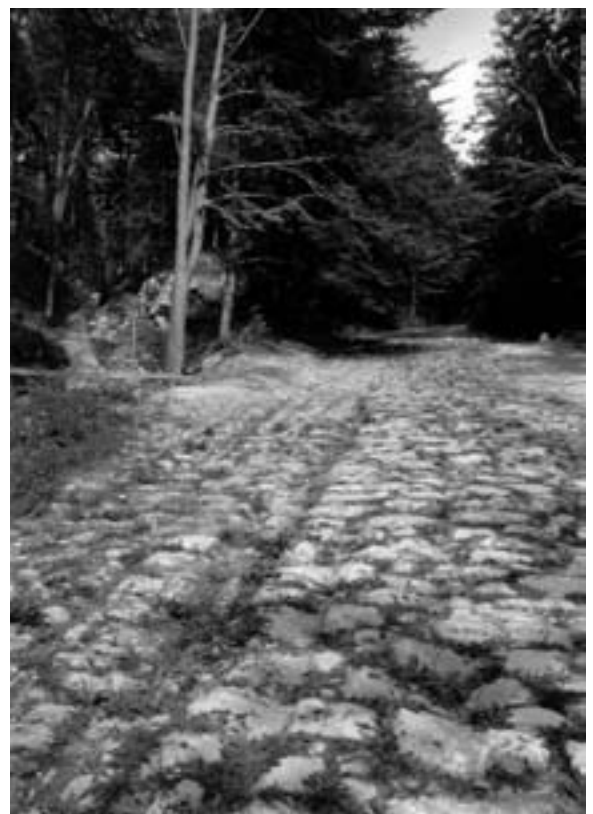
Abb. 1: Geleise in der Blockpflasterung am Stalden bei Holderbank am Oberen Hauenstein (Foto Kantonsarchäologie Solothurn).
