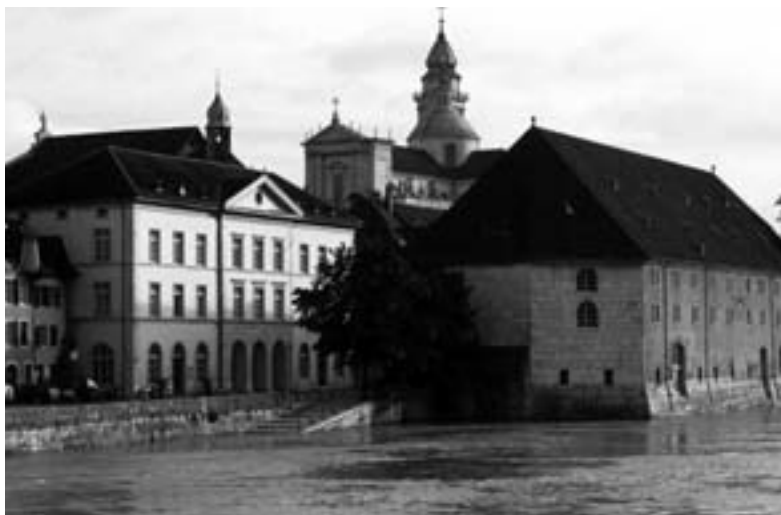
Abb. 2: Das Landhaus von 1722 (rechts) und das Schulhaus «Am Land». Dieses ersetzte 1870 das städtische Kaufhaus, das einst der zweite wichtige Güterumschlagplatz an der Wasserstrasse gewesen war (CD).
