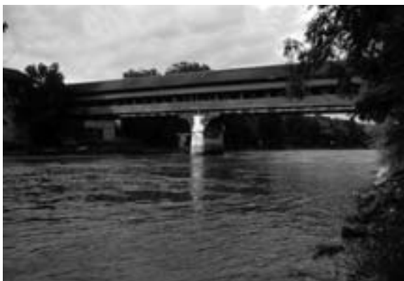
Abb. 2: Fulenbach – eine gedeckte Holzbrücke als Ingenieurbau im Geist des 19. Jahrhunderts (CD).
