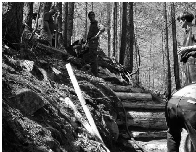
Fig.2 Remise en état du Stockalperweg sur la route du Simplon après les dégâts causés par les intempéries (Objet IVS: VS 1.2–VS 1.4; classification d'après la LPN: importance nationale, segments avec beaucoup de substance, substance et historique) Photo: Ferdinand Pfammatter, Simplon Dorf, 2005.
