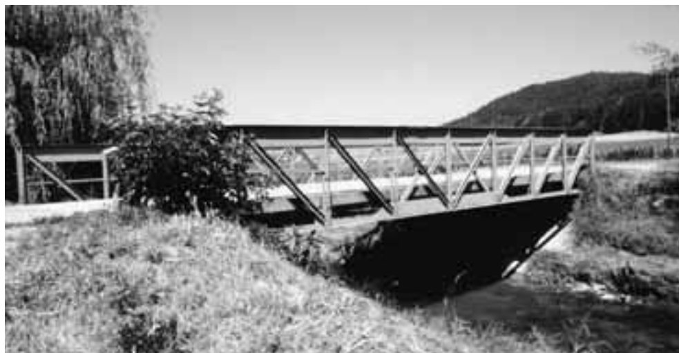
Eisengitterbrücken gibt es im Kanton Schaffhausen nur wenige. Eine von ihnen überquert bei Wilen südlich von Ramsen die Biber.
