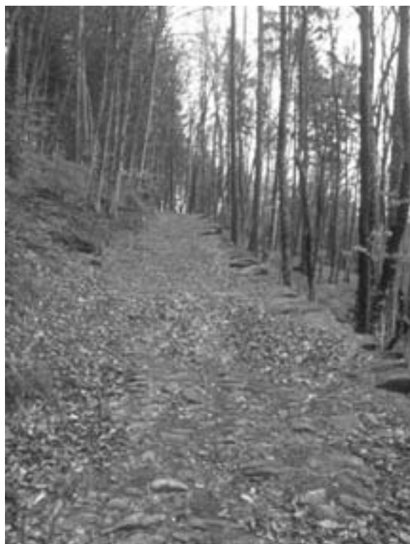
Abb. 41 (unten): Breite Hangwegpartie der Strasse um 1800 mit talseitiger Stützmauer. Ganz deutlich wird, dass es sich um eine in einem Zug neu angelegte Strasse handelt. (SG 121.2, C. Doswald, 1996)
