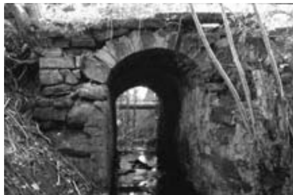
Abb. 55 (rechts unten): Die kleine Bogenbrücke bei Atzenholz an der «Alten Konstanzerstrasse» (SG 50.4.1 / SG 42.1.3) auf der historischen Grenze ist – mit Ausnahme der Stirnseiten – recht gut erhalten. Im engen Einschnitt des Grenzbachs ist sie nur schwer zugänglich. (T. Specker)
