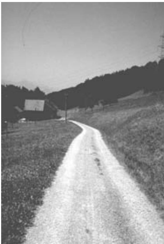
Abb. 64: Geschotterte Wegpartie bei Berg. Sie vermittelt einen guten Eindruck der geradlinigen Wegführung, welche auch längere Hangwegpartien nicht vermeidet. (SG 326, A. Maissen, 2000)
