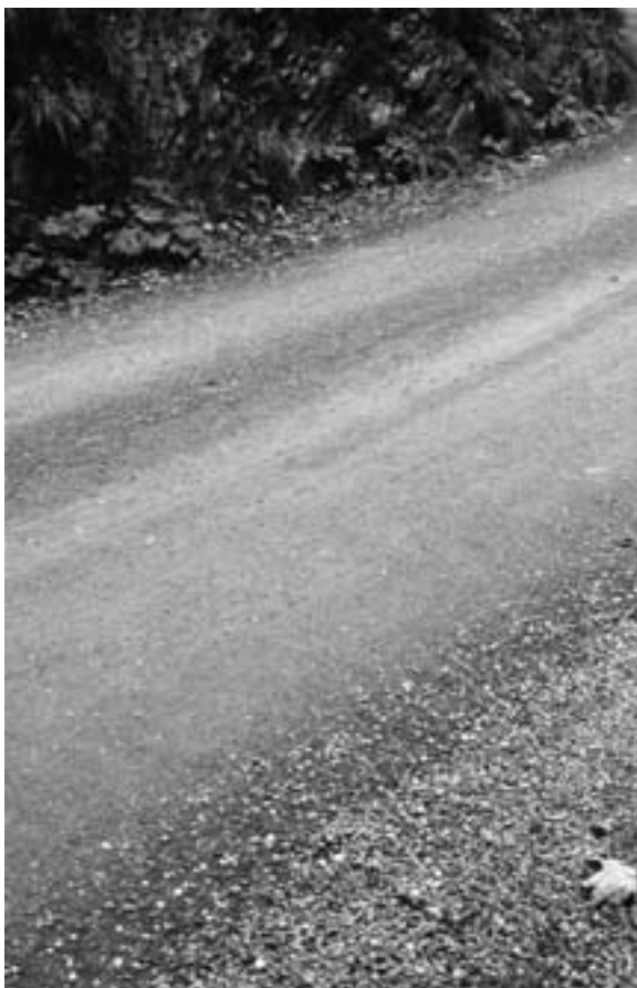
Abb. 27 (oben links): Die Technik der Chausseierung wurde bis in unser Jahrhundert verwendet, ist aber selten geworden. Die Strasse Bad Ragaz–Bad Pfäfers (SG 184) zeigt noch eine chausseierte Oberfläche. (T. Specker, 2006)
