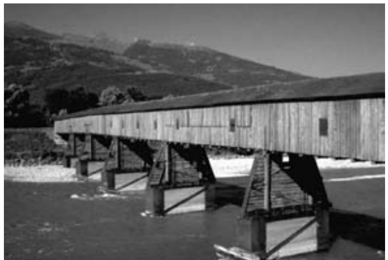
Abb. 51 (oben): Deutlich wird der geringe Holzverbrauch beim System Howe. Es sind auch keine sehr massiven Balken notwendig. (Stadelmann, Werner. Holzbrücken der Schweiz. Chur 1990: S. 274)
