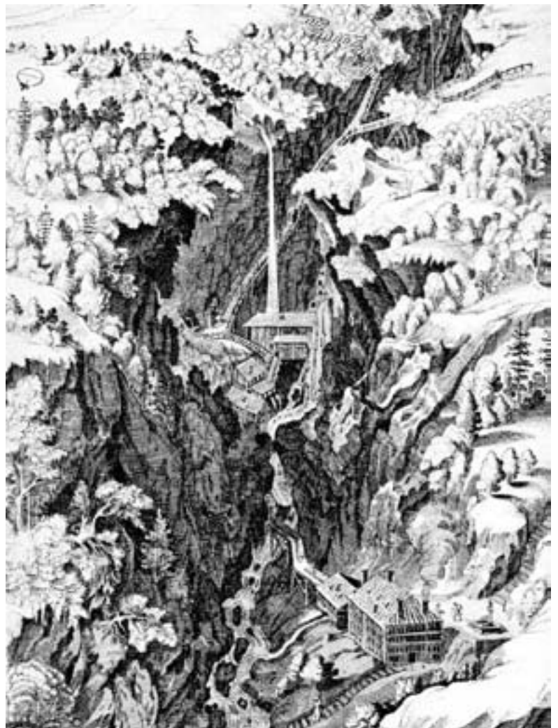
Abb. 67: Himmels- oder Höllenleitern? Die wohl nicht vollständig realistische Darstellung von Merian (1645) lässt immerhin die Beschwerlichkeit des Zuganges erkennen, auch wenn zu dieser Zeit das Bad bereits ausserhalb der Schlucht stand. (Bad Pfäfers – Bad Ragaz 1868–1968, St.Gallen 1968, S. 21)
