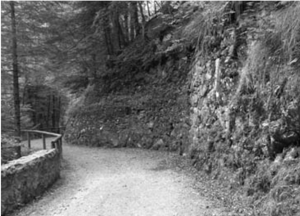
Abb. 30: Besonders schöne und gut erhaltene Stützmauer am südlichen Zugang zur Mühletobelbrücke bei Valens (SG 183.2.2) . Auch an der neuen Strasse erfüllen die teilweise mächtigen Mauern noch ihren Zweck. (T. Specker, 2006)
