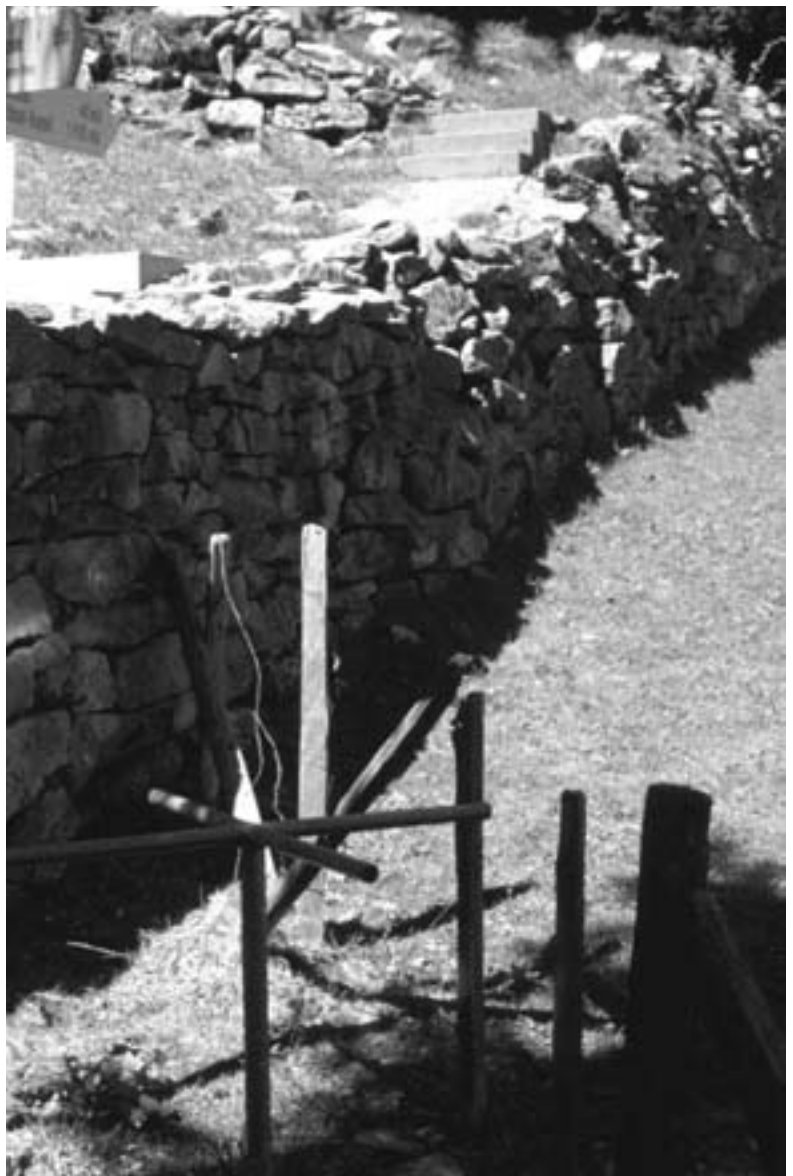
Abb. 76: Grenzmauer zwischen Regelstein und Schorhüttenberg. Quermauer, vorne ein Durchlass für den Weg. (T. Specker, 2006)
