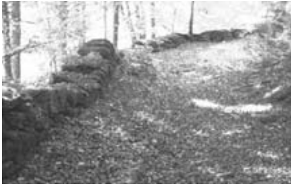
Abb. 42 (oben links): Die Brüstungsmauern der Strasse von 1800 wurden mit teilweise sehr grossen Steinblöcken geschichtet. (SG 121.2, A. Hegland, 1996)
