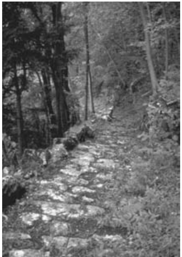
Abb. 43 (oben rechts): Der Weg von Betlis her. Das untere, beidseitig durch trockene Bruchsteinmauern begrenzte Teilstück des Abschnitts. (SG 203.0.1, A. Maissen, 1999)
