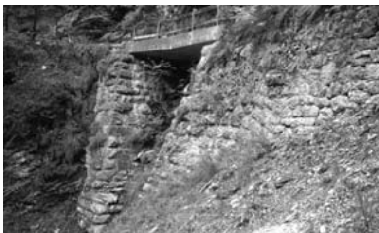
Abb. 69: Ein schöner Wasserdurchlass über einen Seitenbach an der Badstrasse von 1838. Er ist allerdings durch Solenerosion gefährdet. Trotz vieler moderner Überprägungen bietet die Badstrasse mit Randsteinen, Halbgalerien, Durchlässen noch einen Eindruck der damaligen Strassenbaukunst. (T. Specker, 2006)
