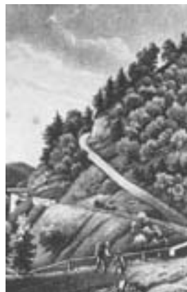
Abb. 11 (links): Die soeben fertig gestellte Staatsstrasse bei Langensteig (SG 44.3) überquert, ausgestattet mit Brüstungs- und Stützmauern, Zaun und Kilometerstein, in einer Kurve mit geringer Steigung den Bach. Hinten zieht sich die Landstrasse von 1784 (SG 44.2.3) steil, schmal und zaunlos den Abhang herunter. (Aquatinta des Lütisburger Landschaftsmalers Johann Baptist Isenring (1796–1860), Rahmenvignette aus dem Gruppenstich «Lichtensteig», um 1837. In: Hollenstein, Johann: Aus der Geschichte von Bütschwil. Bütschwil 1979, S. 208)
