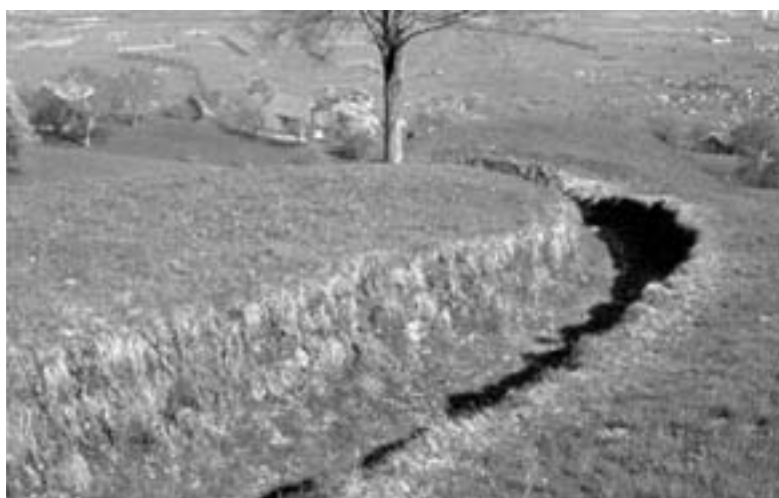
Abb. 37 (oben rechts): Einfacher Querabschlag aus steil gestellten Steinen. (SG 367, A. Maissen, 2001)
