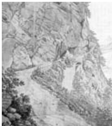
Abb. 9: Wegpartie am Schollberg (Howand) Zeichnung von Jan Haeckert aus dem Jahre 1655. Die Abbildung zeigt das teils aus dem Fels gehauene, teils durch hohe Stützmauern und eine Lehnbrücke gestützte Trasse der Alten Landstrasse. Deutlich wird der notwendige grosse Bauaufwand, um die Schlüsselstelle des Schollbergs zu überwinden. (Werdenberger Jahrbuch 1997, Frontseite)
