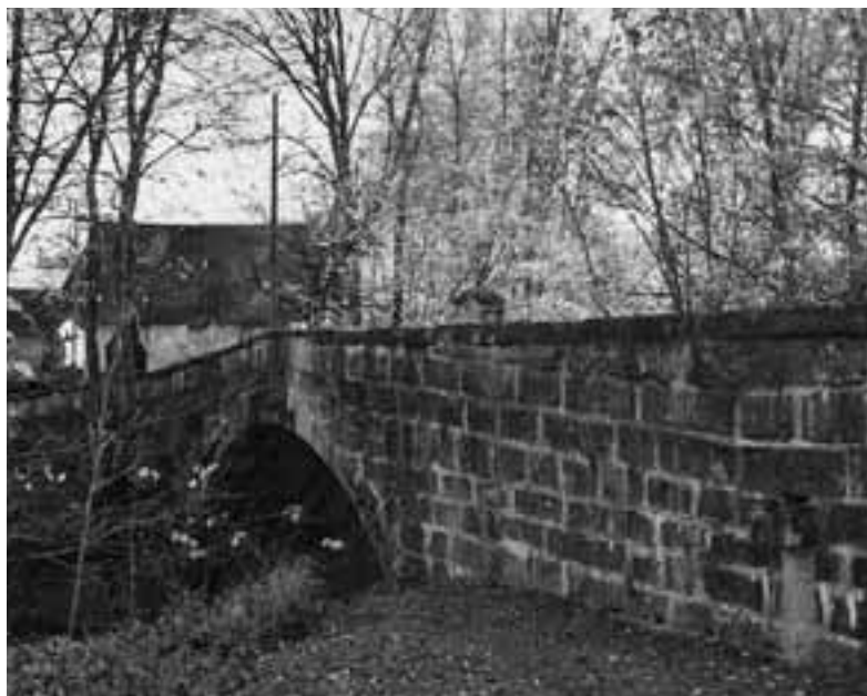
Fig. 5–6 (en haut): Le petit pont de Bressonnaz sur le Carrouge, ouvrage en dos d'âne avec une stèle. En 1700, le bailli bernois propose d'utiliser les matériaux restant du nouveau pont de Bressonnaz pour construire une arche sur le Carrouge et faire passer la route des Gonnelles en dehors des terres fribourgeoises (à gauche). Plan des ponts de Bressonnaz datant du début XVIII e siècle (à droite).
