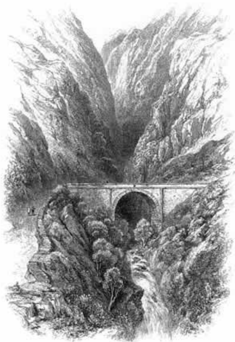
Fig. 17: Gravure du vieux pont du Larrevoin (collection privée). Magnifique ouvrage construit sur la Grande Eau en 1835–1840, abandonné quand le glissement de terrain à la Douve en 1861 obligera à construire un tracé plus en hauteur. Aujourd'hui un puissant viaduc (1964–1965) surmonte le pont du Larrevoin, laissé à l'abandon, dévoré par la végétation et près de s'effondrer...
