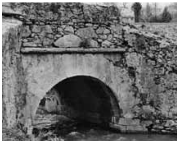
Fig. 8 (en bas): Le Grand-Pont d'Orbe, construit en 1826–1830 comme un maillon essentiel de l'itinéraire de Lausanne à Jougne, est le premier ouvrage à niveau du canton de Vaud.
