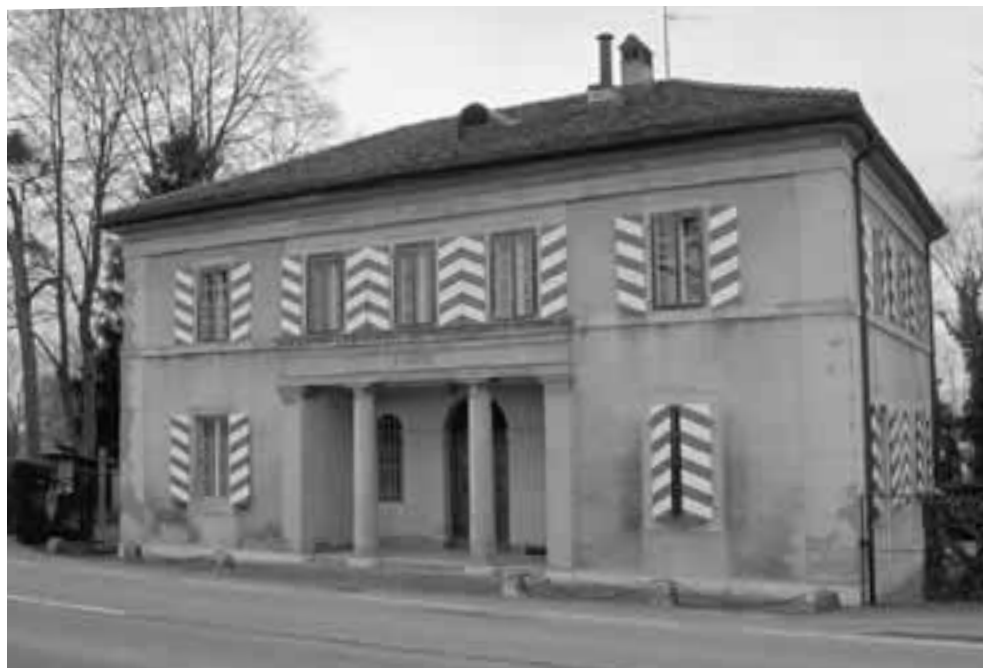
Fig. 16: La maison du péage de Faoug, construite en 1827, sur les plans de François Recordon.
