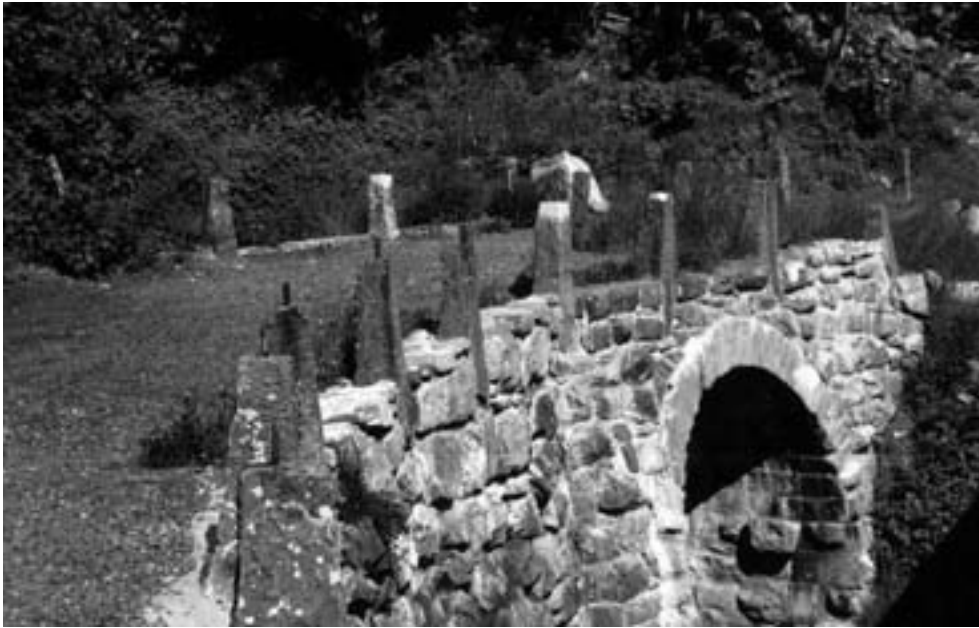
Ein Bijou – ehemalige Brücke der Klausenpassstrasse mit Steinbogen und Randsteinen bei Urigen im Schächental (36; UR 7.3.2).
