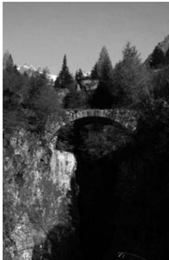
Die Gorezmettlenbrücke (35; UR 4.2.5), Baujahr 1813, ist eine Schlüsselstelle der unvollendeten ersten Fahrstrasse über den Sustenpass.
