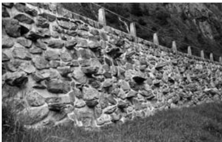
Verblendete Betonbogenbrücken und mit einem Eisenrohr verbundene Kolonnensteine sind typische Merkmale der Sustenpassstrasse von 1946 (oben); die «Useluegi» geben den Mauern ein raues Gepräge (unten).
