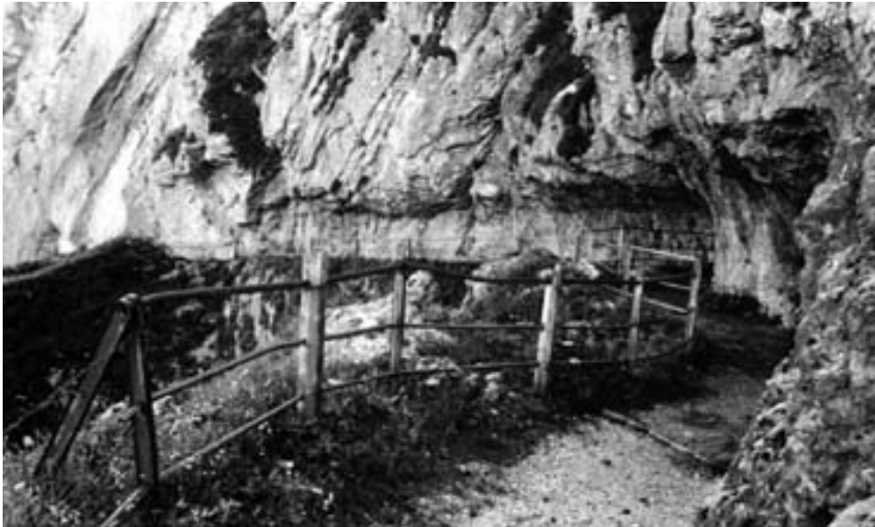
Die in den Fels gesprengte Passage bei «Loch» ist ein attraktives Teilstück des Erschliessungsweges zur Alp Ober Stafel (UR 372).
