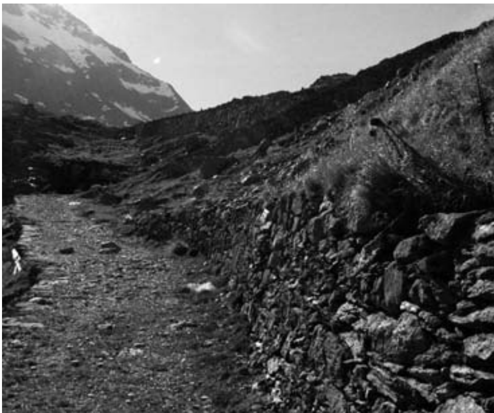
Mit trocken gemauerten Kehren und einem Damm überwindet die unvollendete Fahrstrasse über den Sustenpass von 1811 den Schlussanstieg zur Passhöhe mit gleichmässiger Steigung.
