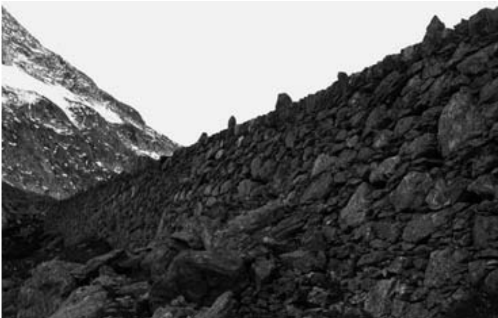
Diese Stützmauer mit den aus ihr herausragenden Randsteinen im Strassenstück zwischen «Chli Chelen» und der Passhöhe steht als eines unter mehreren Beispielen für die kunstvolle Wegbautechnik an der Sustenstrasse.
