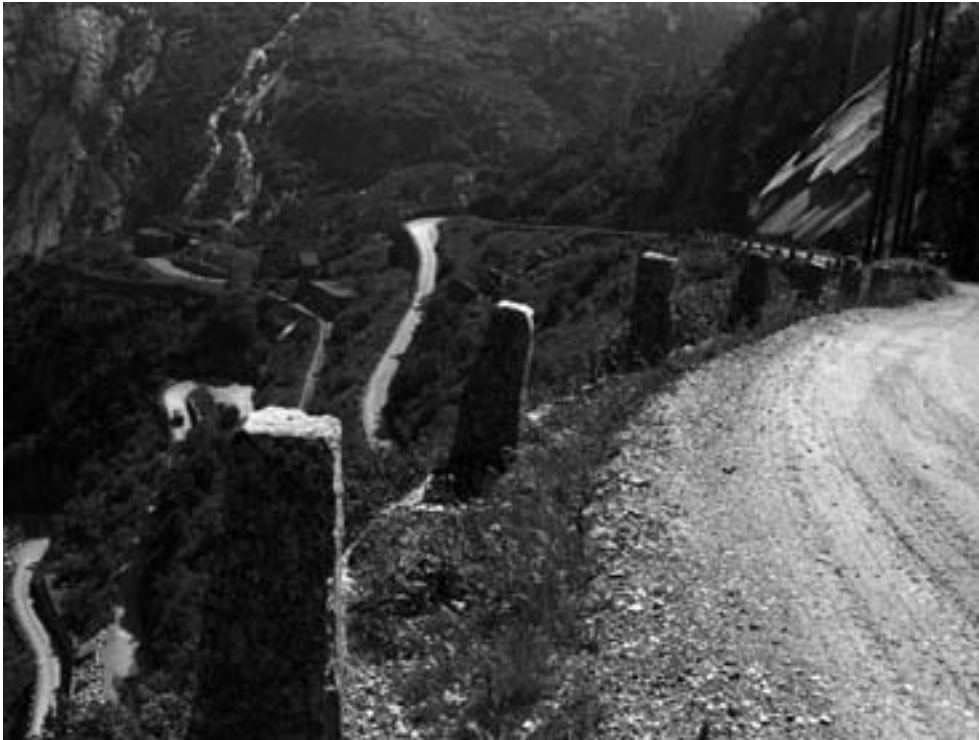
Die Militärstrasse im extremen Gelände hält auch dem Vergleich mit grösseren Kunststrassen im Alpenraum stand.
