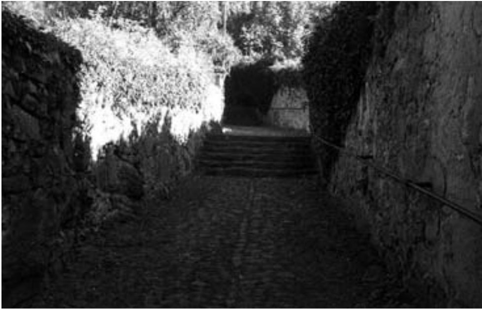
Der Aufstieg von der Pfarrkirche gegen das Kapuzinerkloster ist mit den hohen Mauern, der dichten Pflasterung und den integrierten Treppenstufen äusserst aufwändig gebaut (UR 370.0.1).
