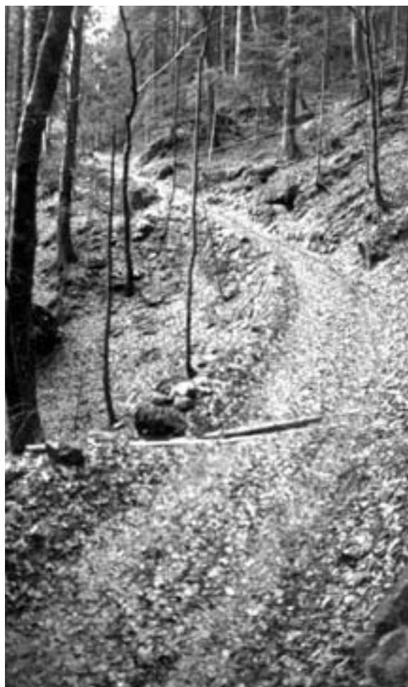
Der Reistweg ist mit grossen Lesesteinen untermauert. Der talseitige Wall soll die Stämme daran hindern, in die Falllinie zu rutschen.
