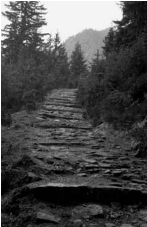
Traditionelles Wegbauhandwerk, Baujahr 1956: Der Gornerenweg im Gorner Wald oberhalb Gurt-nellen.
