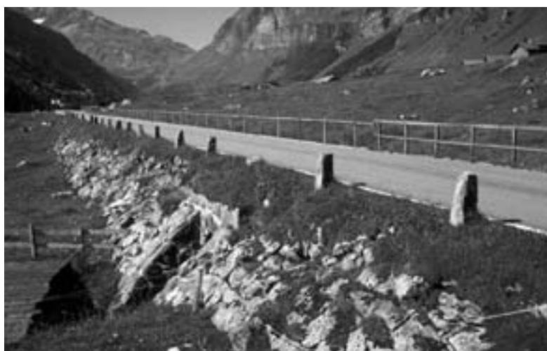
Dämme aus grobem Mauerwerk und Kolonnensteine, die teilweise mit Eisenrohren zu Geländern verbunden sind, charakterisieren die 1900 eröffnete Klausenstrasse bei Jägerbalm (oben) und auf dem Urnerboden (unten).
