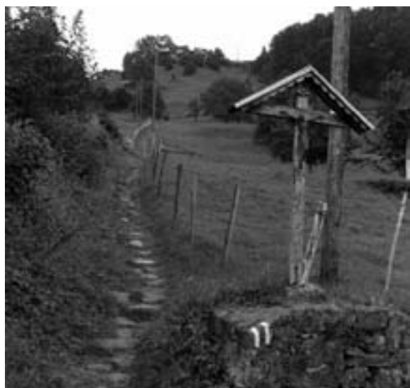
Der Weg bei Schwanden verläuft fast in der Falllinie; die Pflasterung ist stark überwachsen (UR 11.0.7).
