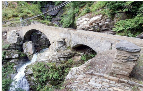
Il Ponte Faidàl restaurato con l'arcata in pietra che ha mantenuto il suo aspetto originale (a sinistra) del XVII secolo. (Foto: Lucchini – Mariotta e Associati SA)
