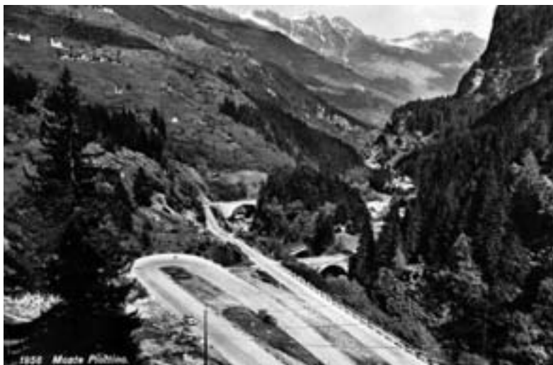
Fig. 7: Dopo quasi un secolo dalla prima proposta di Pasquale Lucchini, la strada evitò finalmente la gola, con due tornanti che la portano all'altezza della galleria. Il fondo in dadi fu sostituito da asfalto nel 1938 (archivio dell'autore).
