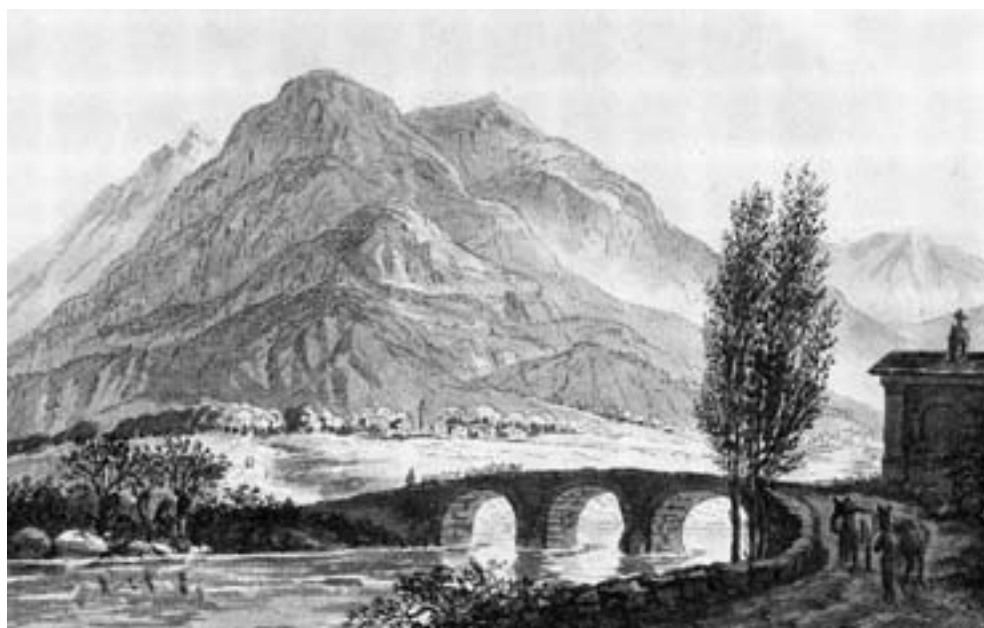
Fig. 7: A fine Settecento, quando fu disegnato da Johann Heinrich Meyer, il ponte della Moesa, costruito poco più di due secoli prima, era ancora considerato uno dei migliori del cantone. I suoi archi a tutto sesto lo innalzavano sopra la strada e necessitava di rampe d'accesso inclinate che rendevano malagevole il transito dei carri. Nonostante quei difetti, fu riutilizzato dalla strada cantonale e completamente ristrutturato solo nel 1848 (Johann Heinrich Meyer, Bey der Moesa-Brücke unweit Bellenz , Kunsthau Zurich).
