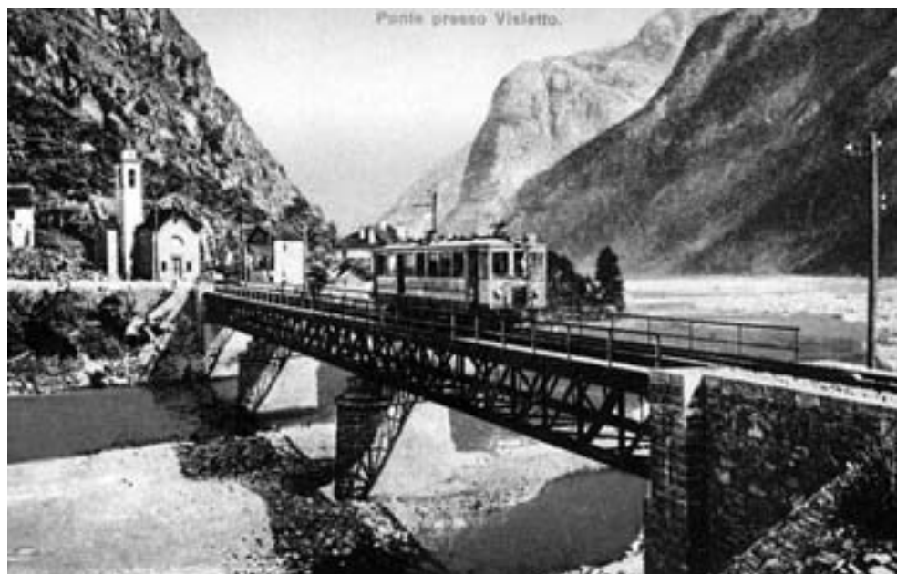
Fig. 12 : Un convoglio della ferrovia Locarno-Bignasco sul ponte di Visletto (Cevio). Come diverse altre, oggi anche questa linea è stata smantellata (archivio dell'autore).
