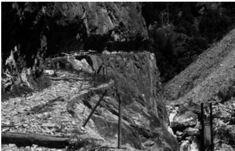
Fig. 5 (in alto): La strada è stata realizzata incidendo la verticale parete rocciosa del massiccio della Töira. I parapetti divelti in primo piano sono la chiara testimonianza della costante e pericolosa caduta di massi (foto Massimo Colombo).
