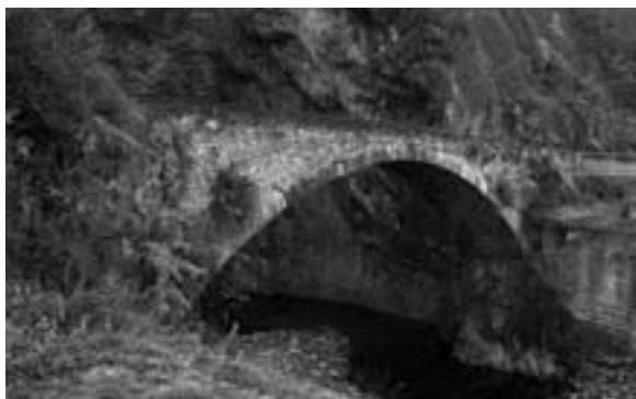
Fig. 2 (in alto): Sulla Lesgiùna venne costruito il primo ponte cantonale. Il manufatto, progettato dall'ingegner Meschini nel 1807, seppur non utilizzato da lungo tempo si conserva ancora in ottimo stato (foto Massimo Colombo).
