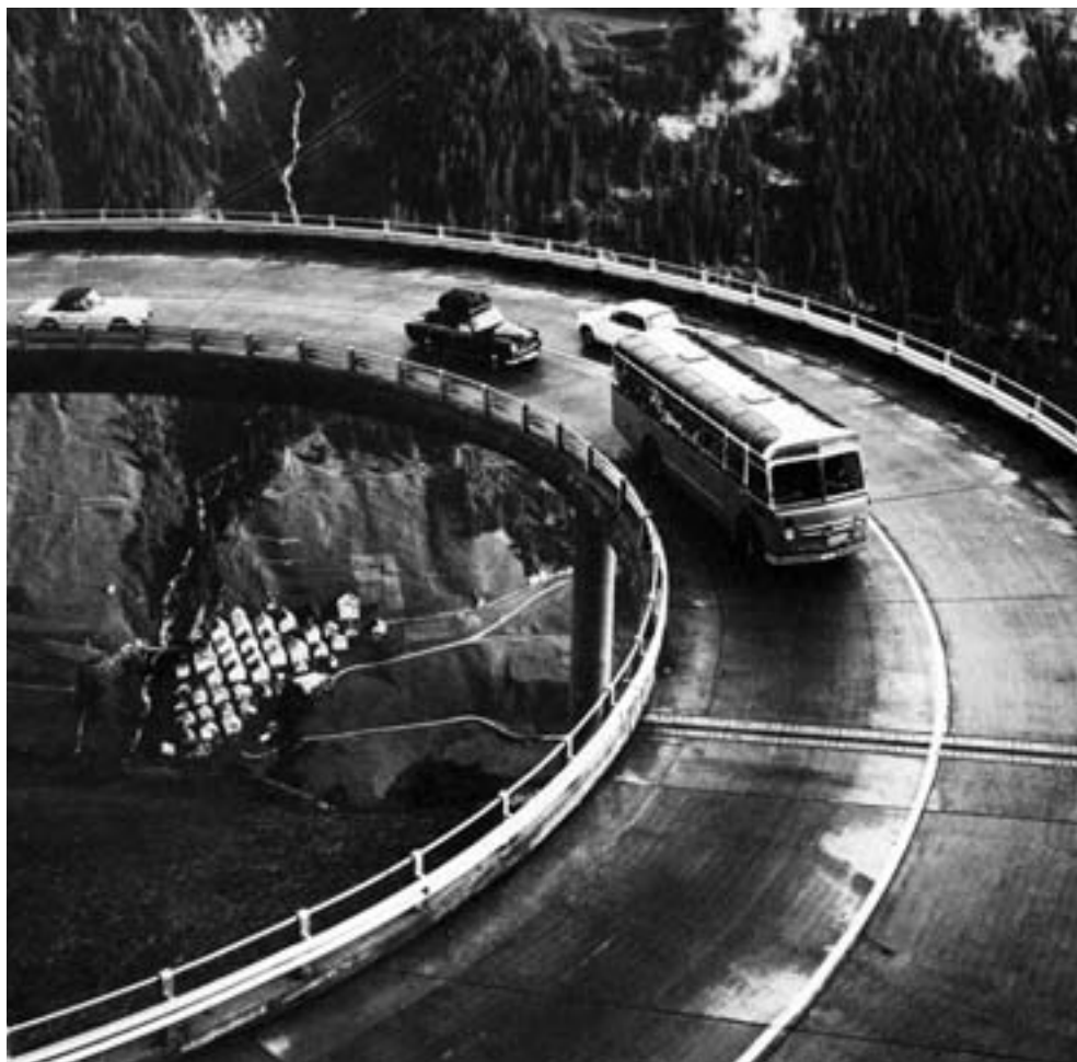
Fig. 15: Nell'Ottocento la strada della Tremola ha imposto lo spettacolo della molteplicità dei suoi tornanti: a fine Novecento i pochi tornanti della semiautostrada del Gottardo impongono la spettacolarità della loro costruzione. Nella foto tratta dal libro di Nething, la frazione airolese di Fontana appare sullo sfondo come un retaggio del passato schiacciato dalla modernità (da Nething, Il San Gottardo ).
