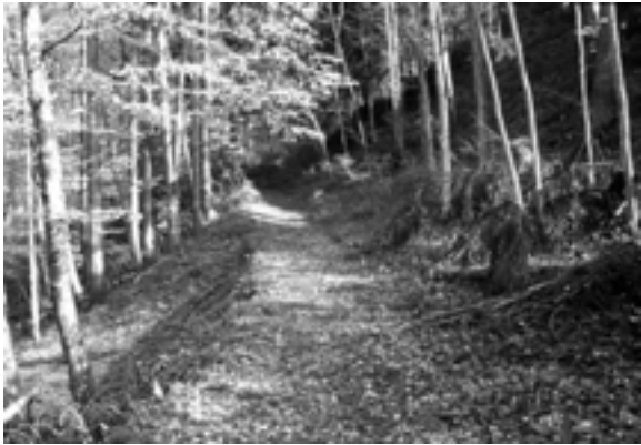
Abb. 13 (oben): Von der kleinen Brücke bei Zweibruggen (AR 330.1.1) aus führt noch der Weg nach Norden (o.I.N.) zur ehemaligen „Hundwiler Leiter“. Er wird aber bald durch einen Erdrutsch unterbrochen, wodurch die Brücke eigentlich funktionslos geworden ist. (T. Specker, 2006)
