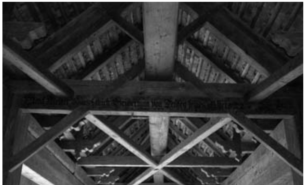
Abb 6: Konstruktionskunst alter Holzbrücken (AR 10.1.2). Brücken waren das einzige Mittel, die tiefen Tobel zu überwinden. An wichtigen Verbindungen musste daher solcher Bauaufwand in Kauf genommen werden. (T. Specker, 2006)
