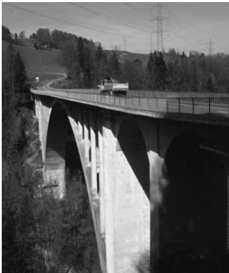
Abb. 46: Die Gmündertobelbrücke von 1908. (T. Specker, 2006)
