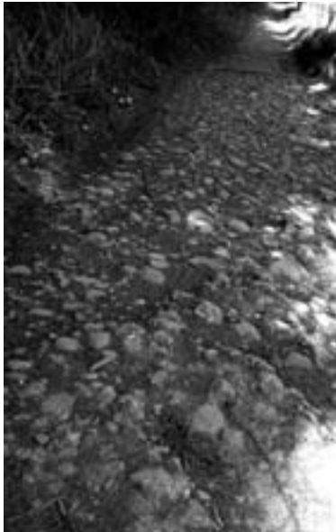
Oben links: Wichtige Verkehrswege wurden geschottert und mit Querabschlägen versehen; im Bild ein Abschnitt auf dem Zugerberg (ZG 233.1.1).
