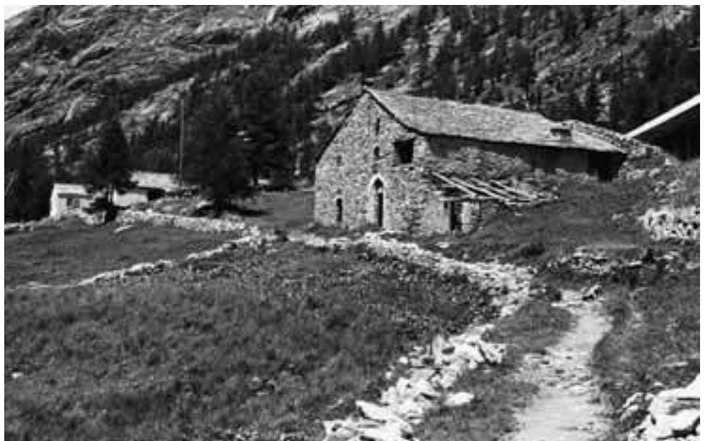
Abb. 1: Die «Alte Suste» in der Engi diente einst den Säumern zum Einlagern der Ware und wohl auch zum Übernachten. Das Holz der ältesten Dachbalken wurde 1537 gefällt. Das Gebäude steht am gepflästerten Saumweg, der von beidseitigen Trockenmauern eingefasst wird (RF).
