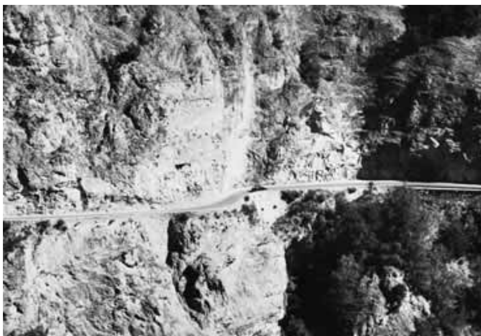
Fig. 7 (en bas) : Aux Pontis, dans le Val d'Anniviers, un virage mène sans transition des prés à l'abîme. La route est creusée à flanc de rocher sur près de 500 m (photo Vanessa Bitz).
