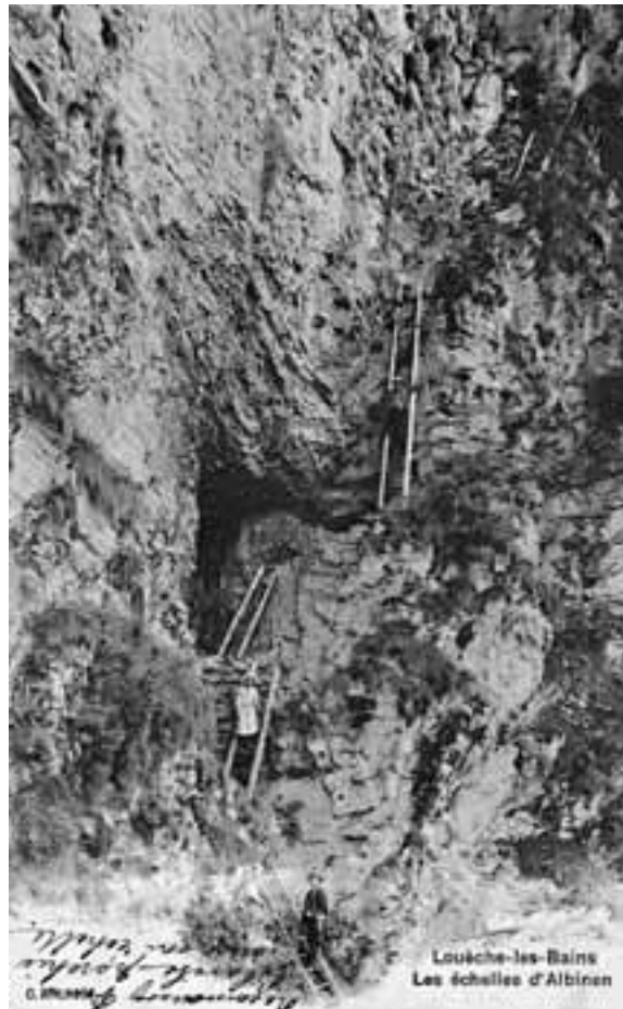
Abb. 4: Der unterste Teil der Albinenleitern; Postkarte nach 1900 (Poststempel 1909). Heute enthält die Passage 8 Leitern mit total 104 Sprossen, 35 Steinstufen und zwei durch Seile gesicherte Quergänge (Archiv K. Aerni).
