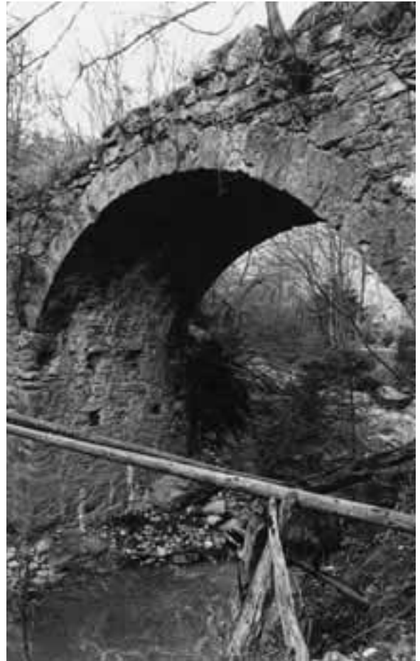
Abb. 2: Die Steinbrücke bei Rumeling, erbaut 1539. Links: In der Mauer des Widerlagers sind mehrere Balkenlöcher ausgespart, die während des Baus zur Aufnahme von Stütz- und Tragbalken dienten. Die Jahrzahl 1742 im Scheitel erinnert an die damalige Instandsetzung (de Kalbermatten 1991: 55).
