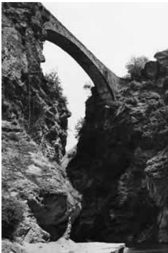
Abb. 6: Die Chibrücke überspannt in rund 48 m Höhe die Matternvispa. Blickrichtung nach Südwesten (de Kalbermatten 1991: 57).
