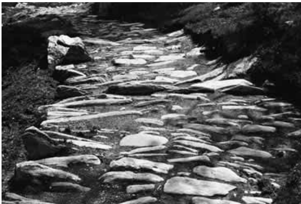
Fig. 11 : Chemin pavé aux abords de Simplon village. Le pavage est composé de dalles plates de différentes tailles, la surface est parfois interrompue par une traverse permettant l'évacuation des eaux de ruissellement, et délimitée par des pierres bordières enchâssées dans le muret de soutènement du pavage (RF).
