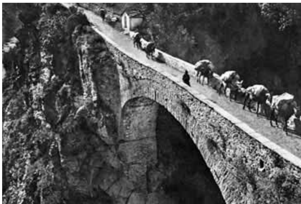
Abb. 3: Die Chibrücke zur Zeit des Warentransports mit Maultieren um 1930. Deutlich sind das aufgemauerte Widerlager auf der Westseite, der doppelte Steinbogen mit den fünf Zugankern, die elegante Aufwölbung der Brückenmitte sowie die Brüstungsmauern aus Bruchsteinen mit den Deckplatten zu erkennen (Imesch 1980, 2/114).
