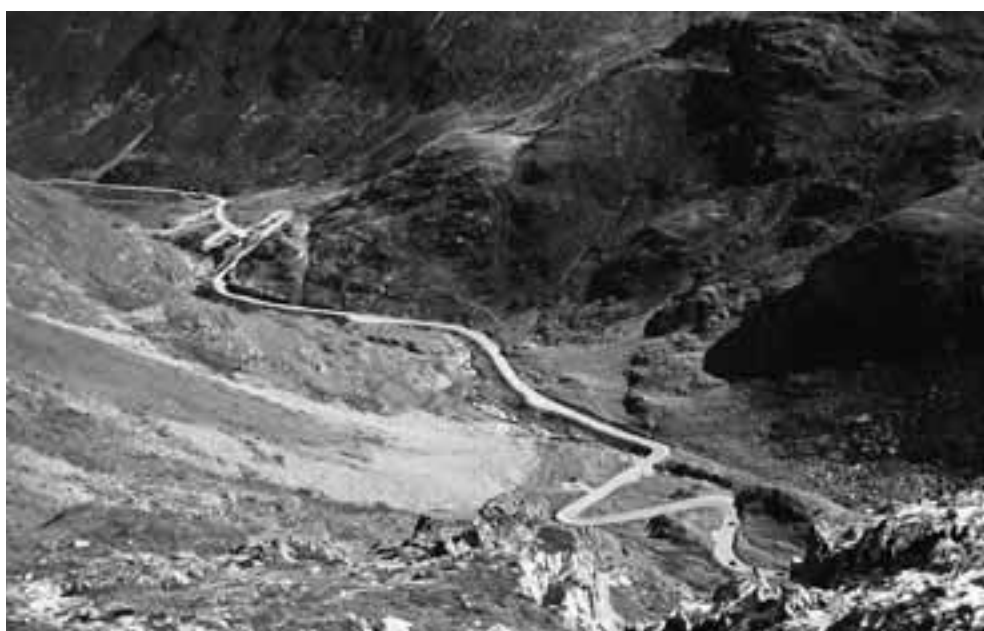
Fig. 1 : Vue d'ensemble de la région de la Comba Martchanda et de l'Hospitalet (en haut à gauche), et du pont de Nudry (en bas à droite; SB)
