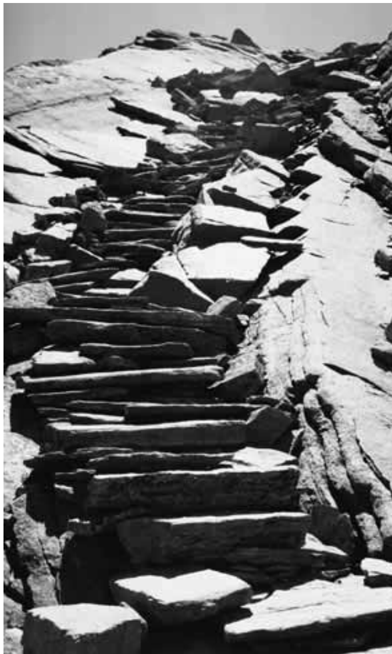
Fig. 12: Une des rampes d'escalier les plus fameuses de Suisse est celle du Monte Moro. Le rocher a été taillé à intervalles réguliers et une série de dalles forme un impressionnant escalier (KA).
