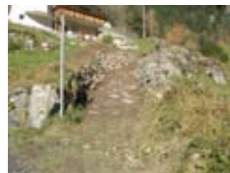
la via storica del Susten dopo il ripristino. Foto: Theiler Landschaft GmbH.
