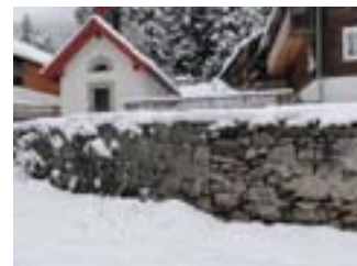
il segmento destro del muro è stato ripristinato con il metodo classico della muratura a secco. Il segmento sinistro, invece, è stato intonacato con malta. Foto: Fredi Bieri per l'Ufficio federale delle strade (USTRA).
