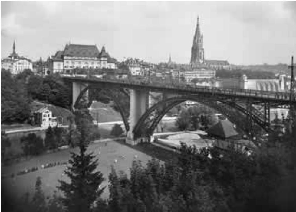
Abb. 11 (oben): Die 1881–1883 erstellte Kirchenfeldbrücke in Bern ist ein eindrückliches Beispiel einer Stahlbogenbrücke. Sie wurde in erster Linie zur Erschliessung des Kirchenfeldquartiers im Süden der Altstadt erbaut, diente aber auch dem Verkehr in Richtung Berner Oberland. Aufnahme um 1915 (EAD, Sammlung Wehrli).
