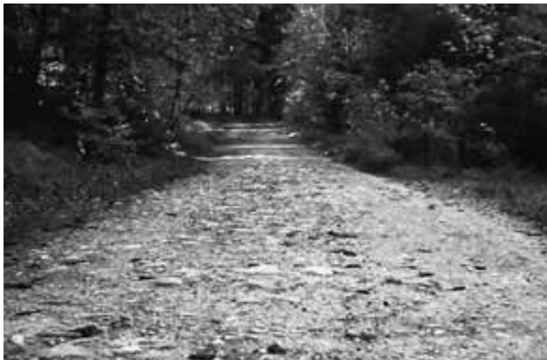
Abb. 2: Ein aufgelassener Abschnitt der Neuen Aargauerstrasse bei Schönbühl vermittelt einen Eindruck von der Breite und Beschaffenheit der Chaussée aus dem 18. Jahrhundert (HS).
