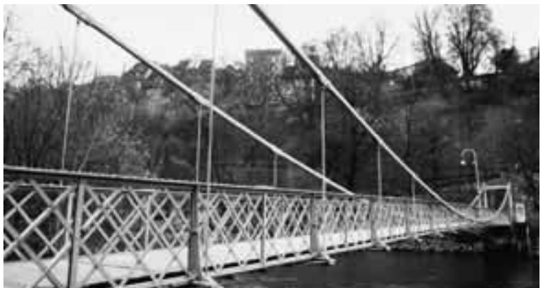
Abb. 14 (unten): Der Altenbergsteg in Bern von 1857 ist eine der ältesten Hängebrücken der Schweiz und die einzige noch erhaltene Kettenbrücke. Die Kettenglieder sind geschmiedet, die Gitterträger gegossen (GS).
