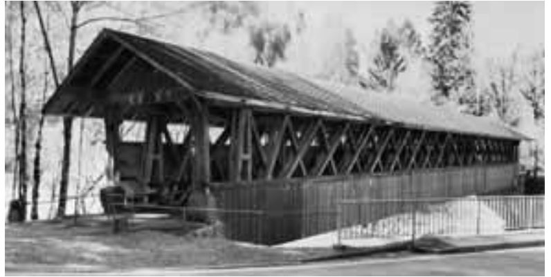
Abb. 5 (links): Die Winterseybrücke bei Hasle bei Burgdorf, Baujahr 1839, ist mit einer Spannweite von 58 m die längste Holzbogenbrücke der Schweiz (Foto Hans Schüpbach).
