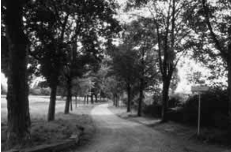
Abb. 5: Die Bolligenstrasse ist im Bereich der Waldau mit von Art und Alter her gemischten, typischen Alleebläumen gesäumt. Der Abschnitt wird von einer neueren Fahrstrasse entlastet und hat daher den traditionellen Charakter bewahrt (GS).
