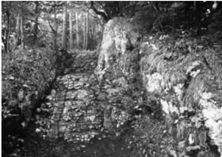
Abb. 6: Der Felseinschnitt am Mont Raimeux östlich von Moutier. Die Geleisestrasse weist hier eine mittlere Steigung von 25 % auf (GS).
