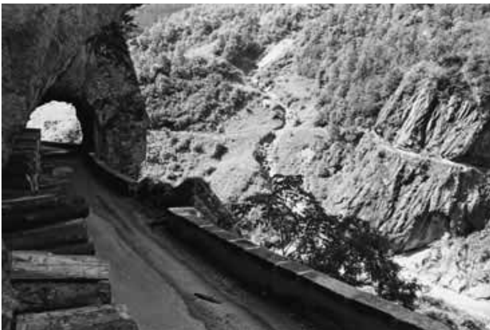
Abb. 1: Erlebnislandschaft Susten–Grimsel: In der landschaftlich und verkehrsgeschichtlich spektakulären Passage bei der Sprengfluh an der Grimsel haben sich Verkehrswege aus verschiedenen Epochen erhalten, so die Kunststrasse von 1894 (links), die heute in einem Tunnel umfahren wird, und der in den Fels gehauene Saumweg von 1774 (rechts; HM).
