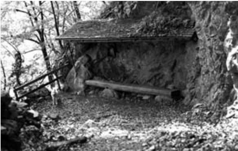
Oben: Der «klassische» Typ des Gruebis – hier die Schutzhütte bei Zwüschet Mythen (SZ 456). Der Holzbau ruht auf trocken gemauerten Grundmauern.
