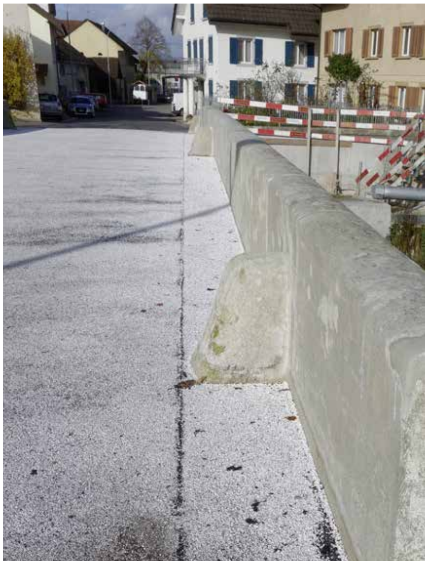
Paracarro del parapetto in muratura del Surbbrücke a Döttingen, Cantone di Argovia.
