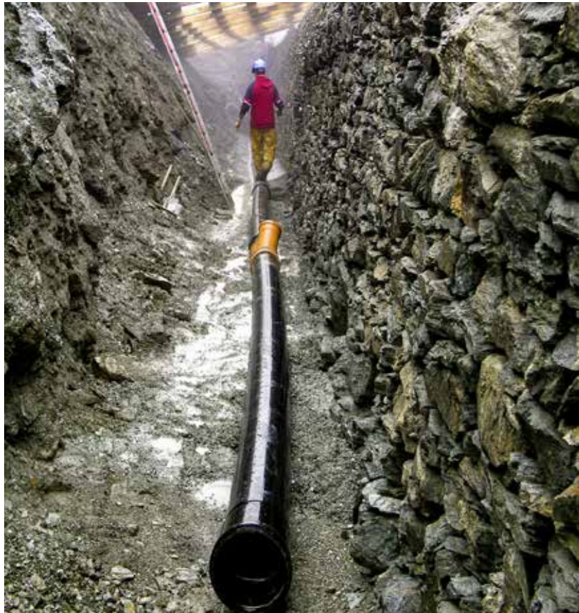
Il sistema di drenaggio è d'importanza fondamentale per la longevità della galleria; in foto un nuovo tubo di deflusso.
