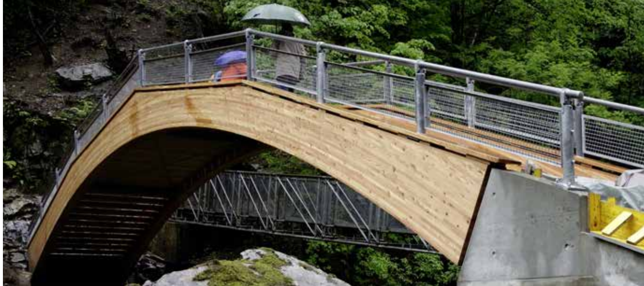
Ponte ad arco sull'Isorno durante la costruzione; progetto di Christian Menn.
