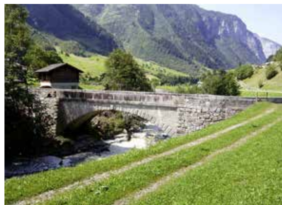
Parapetto in muratura su un ponte ad arco nel Cantone di Berna.
