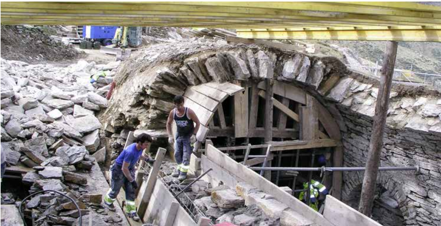
Nel corso del complesso restauro la galleria è stata in gran parte smantellata e ricostruita.
