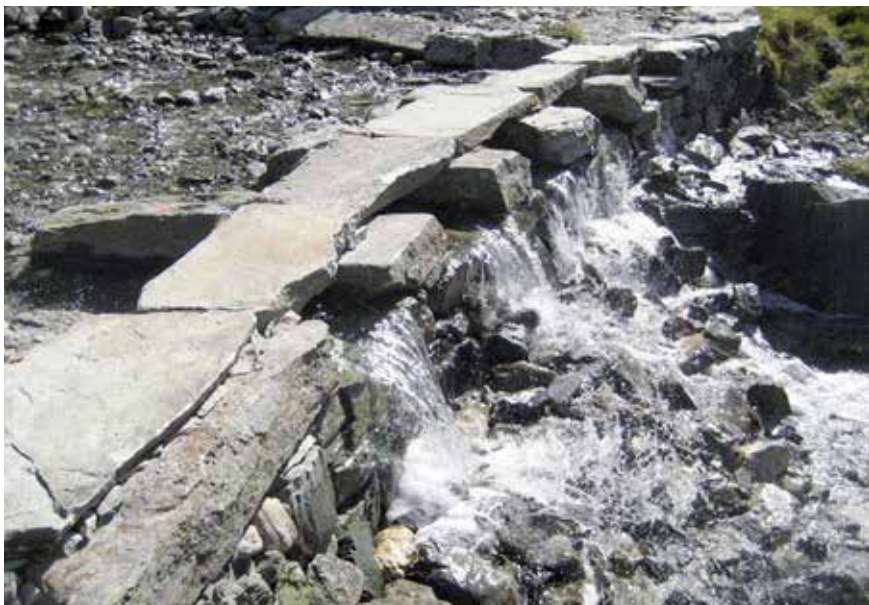
Attraversamento in pietra lavorata di un ruscello sulla mulattiera storica del passo del Settimo.
