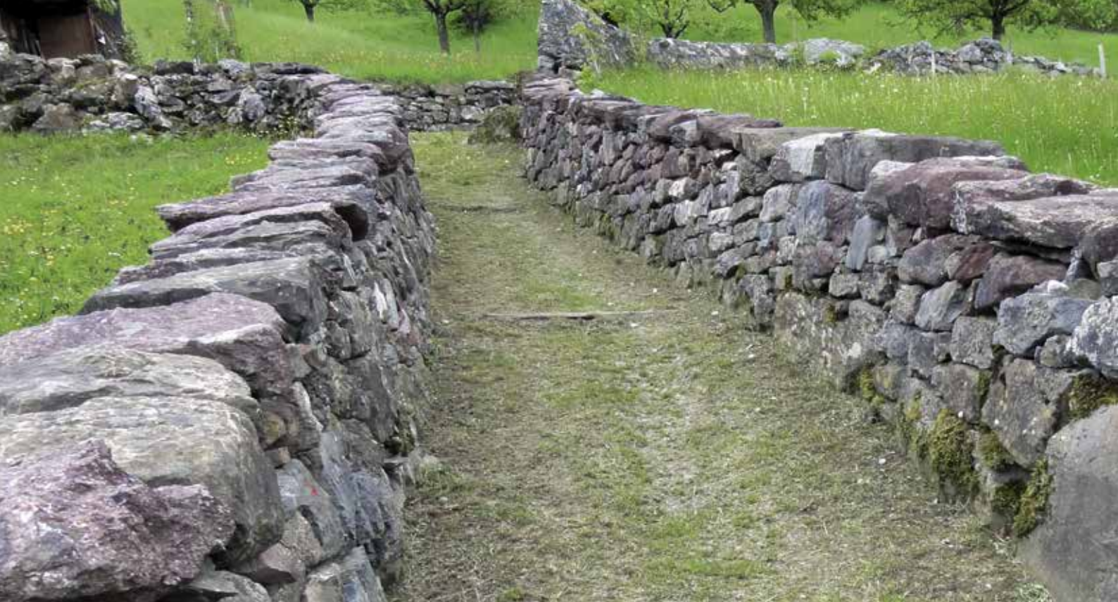
Muri a secco lungo la via di comunicazione storica tra Ennenda e Uschenberg (Cantone di Glarona).
