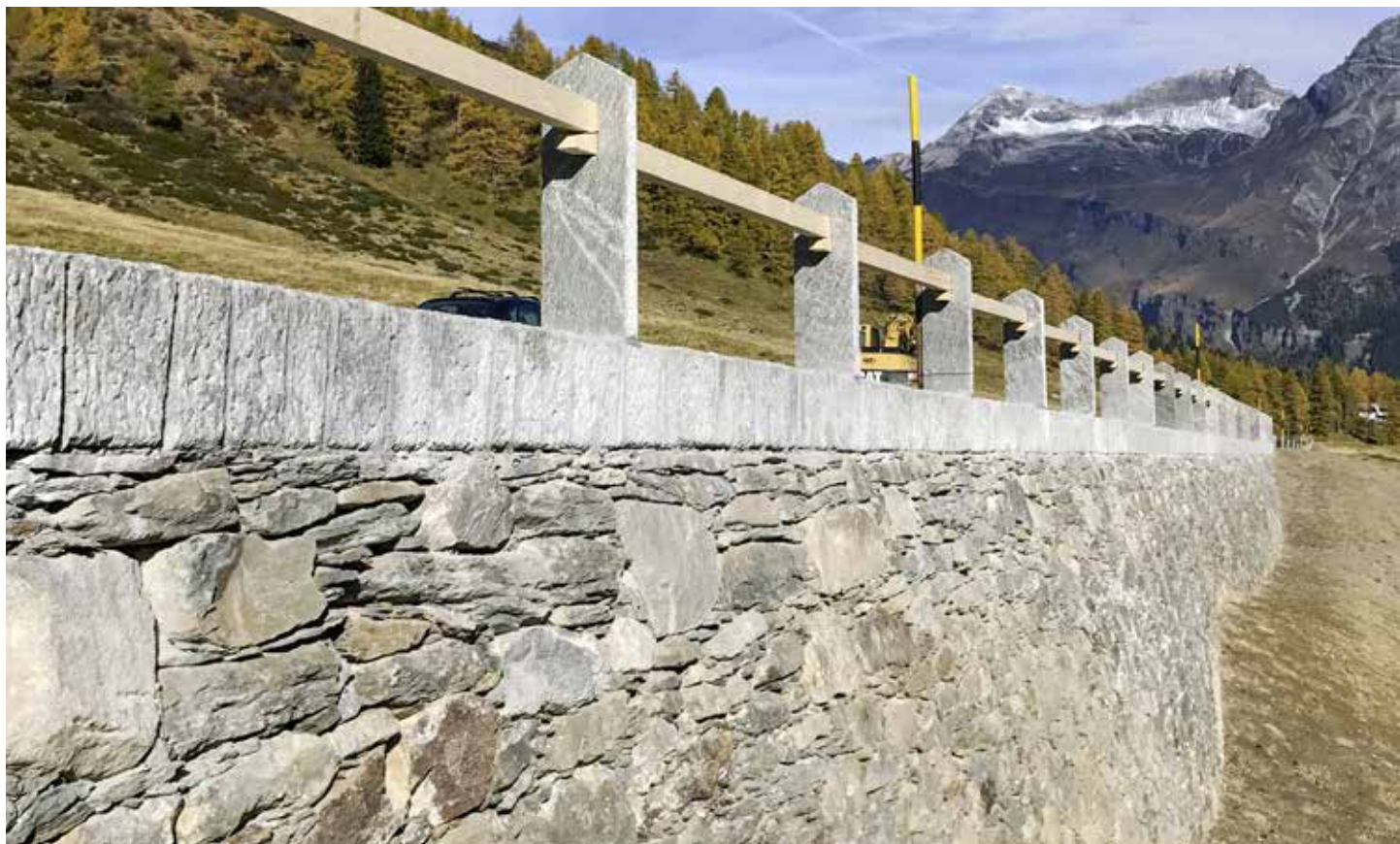
Muro a secco del ponte di marmo al Passo dello Spluga.
