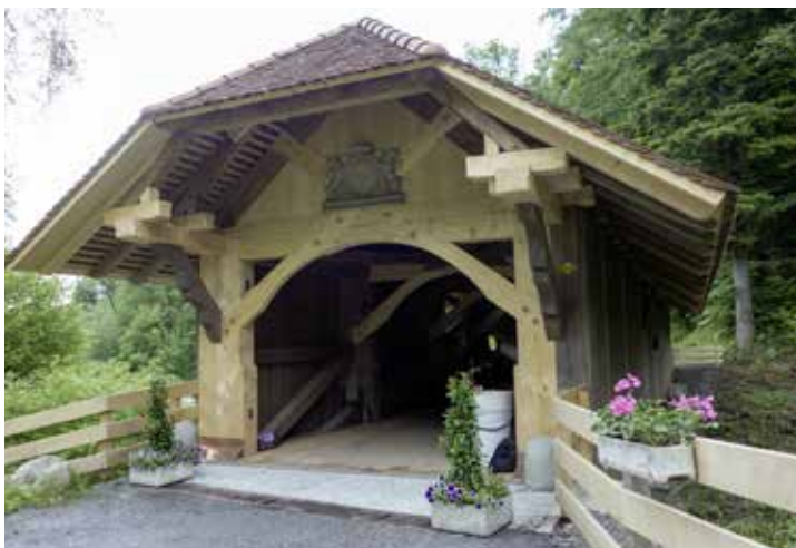
Il ponte di Hergiswald preserva forme e materiali storici.
