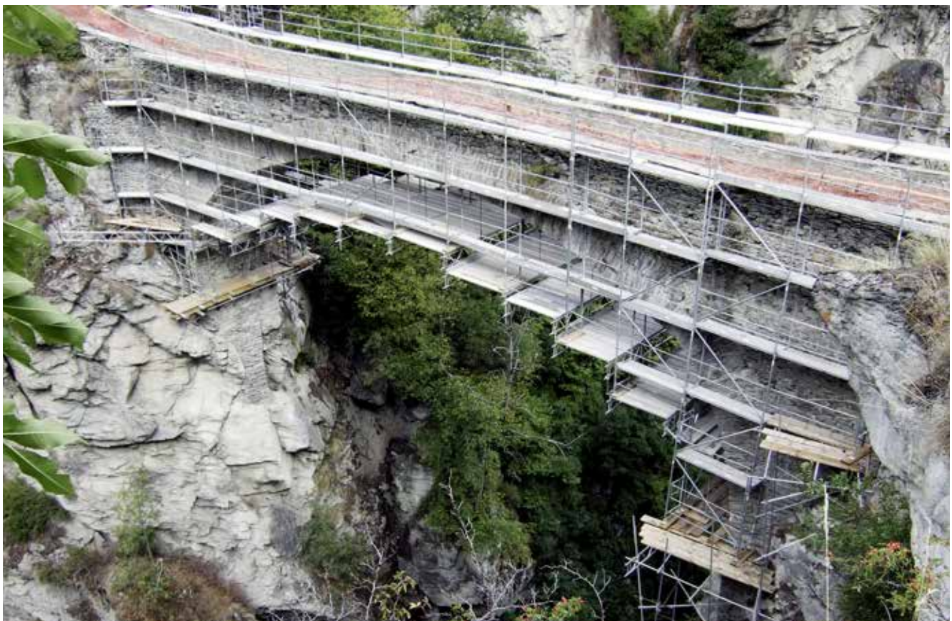
L'imponente impalcatura del Chibrücke poggia sui piloni del ponte.
