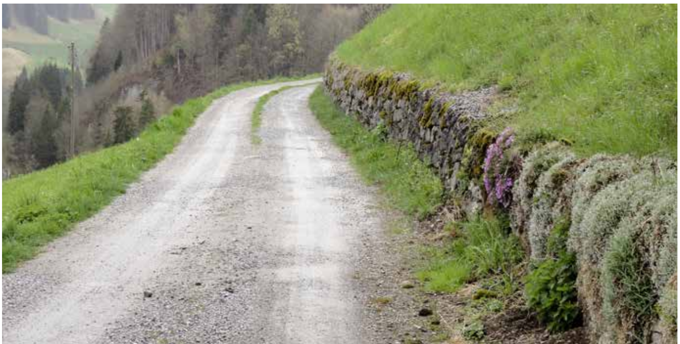
Imbrecciatura su una via agricola ripristinata tra Wüstenbach e Seeweide nel Cantone di Berna.
