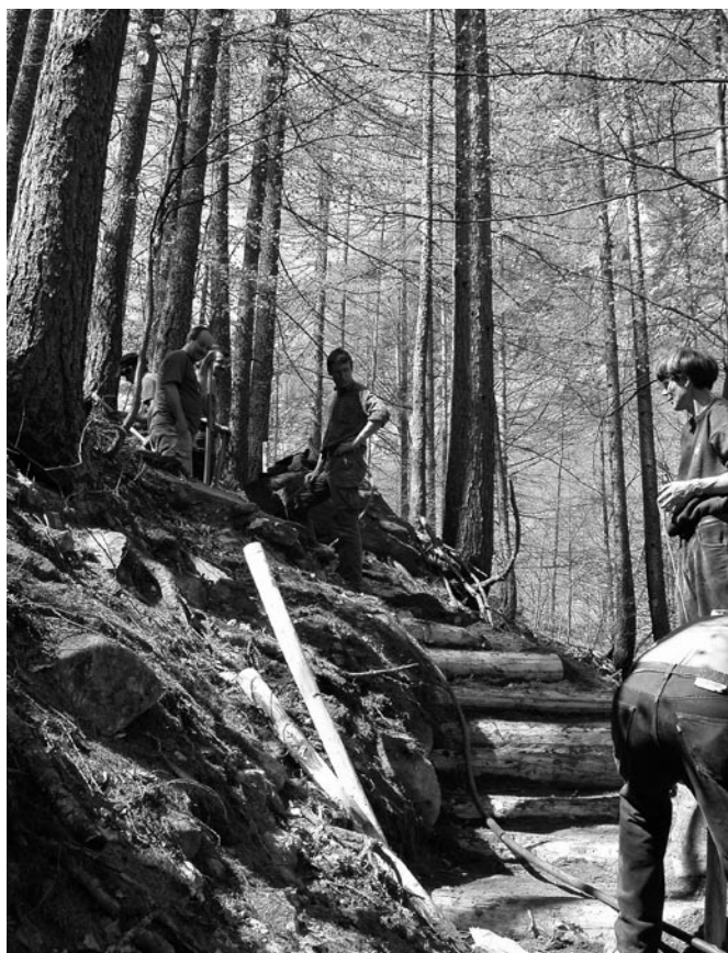
Abb.2 Instandstellung des Stockalperweges am Simplon (VS) nach Unwetterschäden (IVS-Objekt: VS 1.2–VS 1.4; Bedeutung nach NHG: national, Abschnitte mit viel Substanz, Substanz und Verlauf) Foto: Ferdinand Pfammatter, Simplon Dorf, 2005
