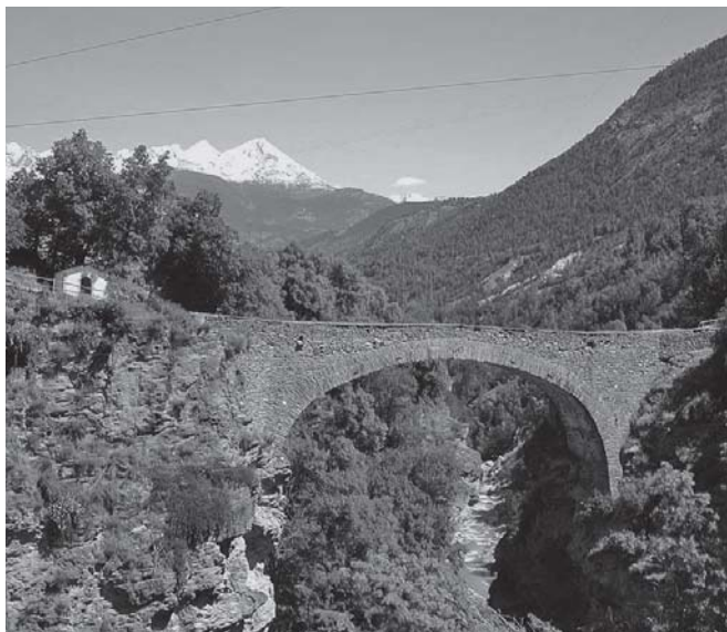
Abb.1 Die Chibrücke bei Stalden im Wallis Foto: F. Bieri
