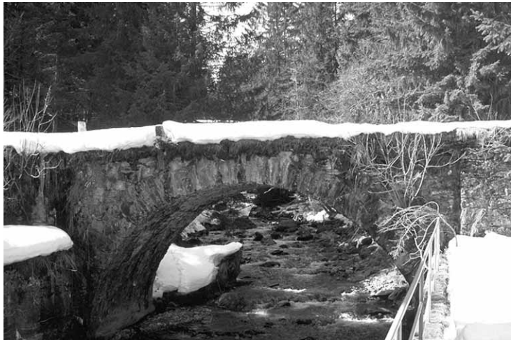
Pont de pierre en moellons à Arche. Fig. 7 (BS, 25. 3. 2003)
