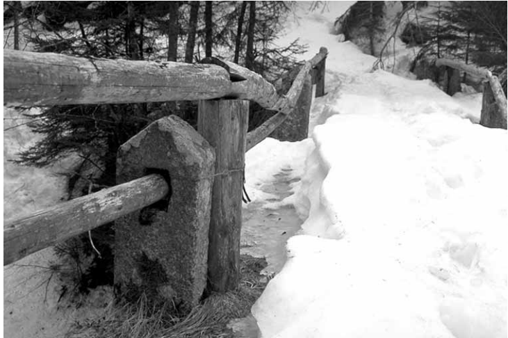
Balustrade enchâssée dans la pierre bordière sur le pont de Rières Fig. 6 (BS, 25. 3. 2003)
