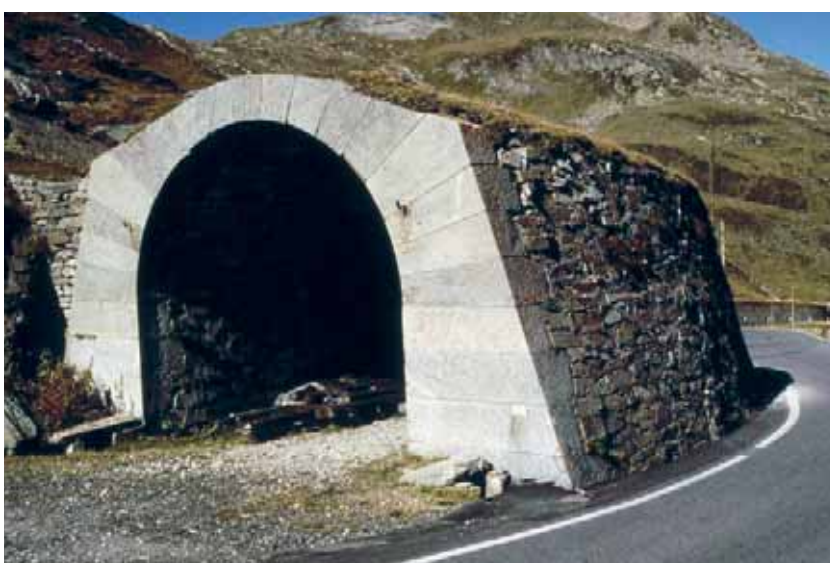
Galleria paravalanghe sul versante settentrionale del Passo dello Spluga GR. Negli anni Quaranta del 1800 il valico venne reso transitabile in modo sicuro anche d'inverno grazie a queste gallerie (ViaStoria/Arne Hegland).
