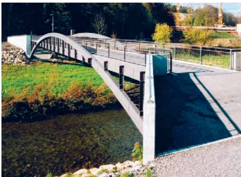
Dislocamento. Nel 1998–99, il Höcklerbrücke del 1866 sulla Sihl a Zurigo-Leimbach ZH è stato sollevato dalle sue spalle originali, deposto a terra per le riparazioni e posato su nuove spalle più a monte. Nell'operazione la portata del ponte è stata ridotta, con un arco non autoportante, e quindi dotato di spalle e piattaforma stradale nuove. Il ponte oggi è parte della rete stradale di traffico lento (Basler & Hofmann / Michael Ruf).
