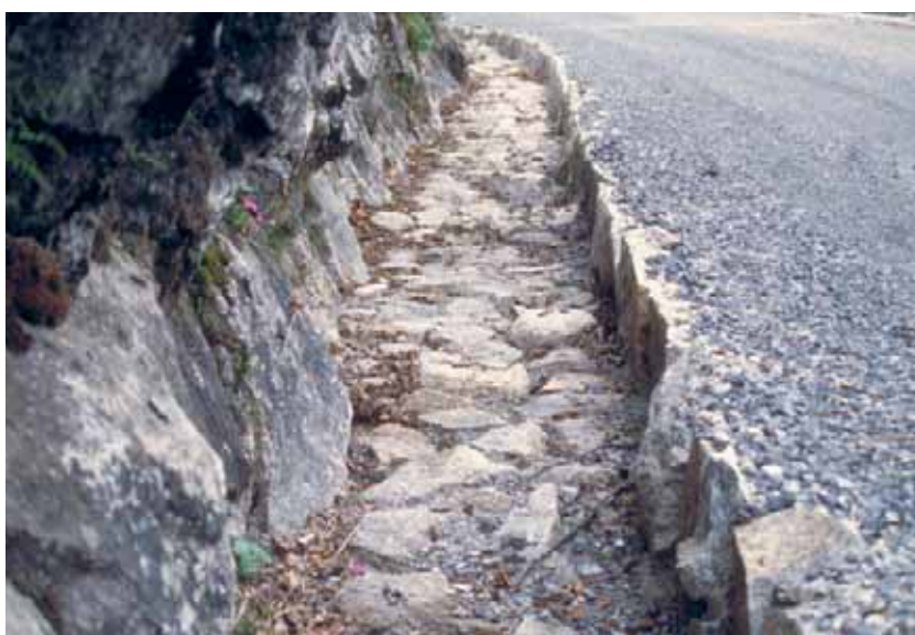
Fosso laterale di fattura artigianale costruito con pietre di cava e un letto di pietre. Antica strada del Gottardo nella Schöllenen UR (ViaStoria/Arne Hegland).
