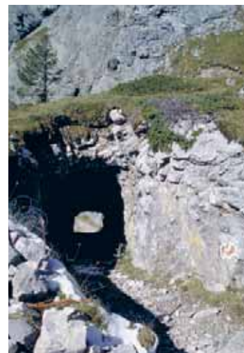
Il traforo di questo semplice tunnel non rivestito nella roccia cristallina risale al restauro nel XIX secolo della mulattiera di Rawil, sul lato vallesano (ViaStoria / Vanessa Bitz).
