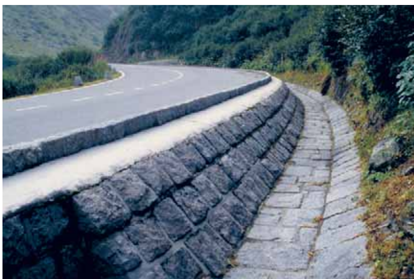
Fosso laterale rivestito di blocchi di pietra squadrate e cementati. La forma rigidamente geometrica non rende giustizia alla strada storica. Strada del Gottardo UR (ViaStoria/Arne Hegland).
