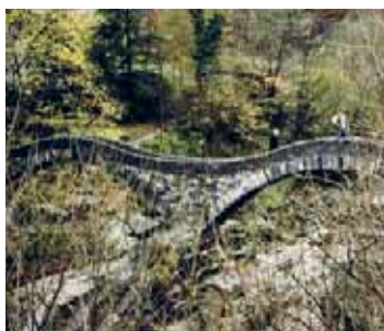
Ricostruzione parziale. Il ponte sulla Verzasca a Lavertezzo TI è un buon esempio di perfetta ricostruzione eseguita artigianalmente di un arco crollato. Il modello dell'arco ricostruito negli anni Cinquanta del 1900 è stato quello conservatosi (Via Storia/Arne Hegland).
