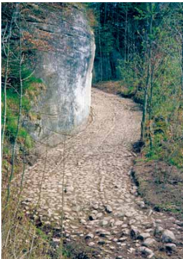
Questo acciottolato in sassi di fiume forma una carreggiata stradale suddivisa da file di pietre. Lungo la Sense, presso Heitenried FR (ViaStoria / Fredi Bieri).
