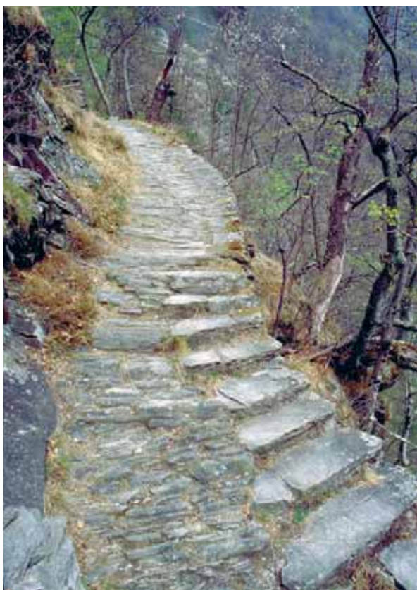
Mulattiera molto ben strutturata in un tratto ripido. Il selciato è in file di lastre posate di taglio affiancate da gradini di lastre di pietra. Tra Promontogno e Soglio GR (ViaStoria / Guy Schneider).
