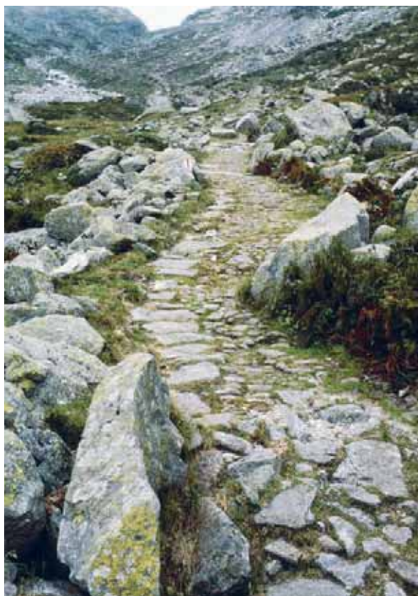
La mulattiera del Gottardo al Mätteli tra Hospental UR e il culmine del valico. Portata alla luce, la struttura del selciato è divenuta chiaramente visibile (ViaStoria / Heinz Dieter Finck).
