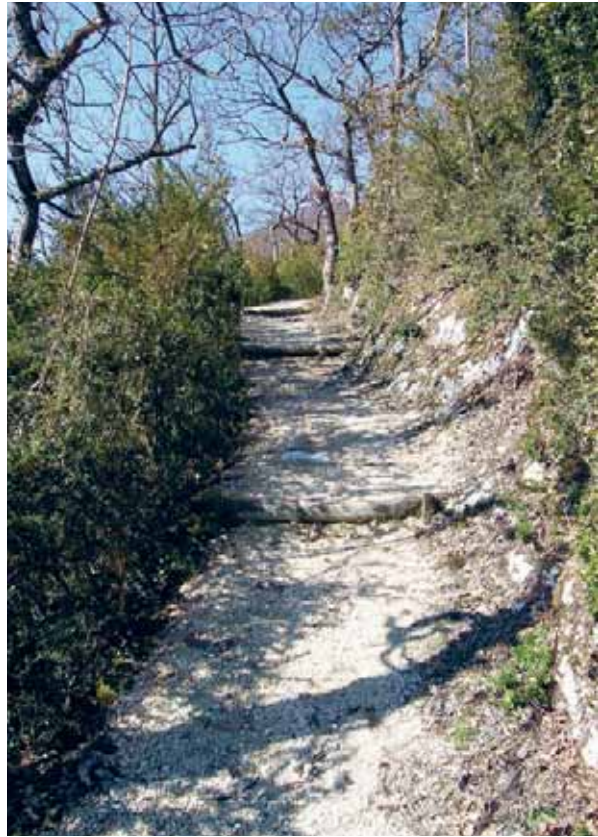
Ghiaia: un caratteristico percorso pedonale, con inghiaatura in calcare del Giura su ripido terreno roccioso. La «Jakobsleiter» presso Egerkingen SO (ViaStoria/Cornel Doswald). Cfr. p. 54.
