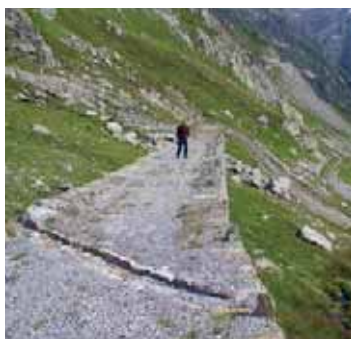
La canaletta trasversale in pietra inserita nella superficie viaria consente il passaggio dei veicoli. Antica strada del Passo del Susten UR (ViaStoria/Guy Schneider).
