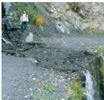
Guado in muratura nelle Alpi, con un alto muro di sostegno sul lato a valle, lungo l'antica strada della Binntal VS (ViaStoria/ Guy Schneider).
