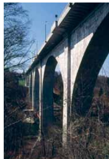
Ampliamento ben realizzato. La piattaforma stradale a sbalzo del viadotto di Pérolles a Friburgo FR, con mensole e parapetti è stata progettata ex novo come la cappella contemporanea (ViaStoria / Cornel Doswald).
