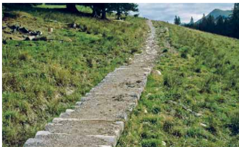
Un camminamento a tondelli con copertura in ghiaietto, segmento di un percorso pedonale attraverso una zona umida in pendio. Nello Schwendeli presso Glaubensbielen OW, sulla strada per Sörenberg LU (ViaStoria / Arne Hegland). Cfr. p. 63.
