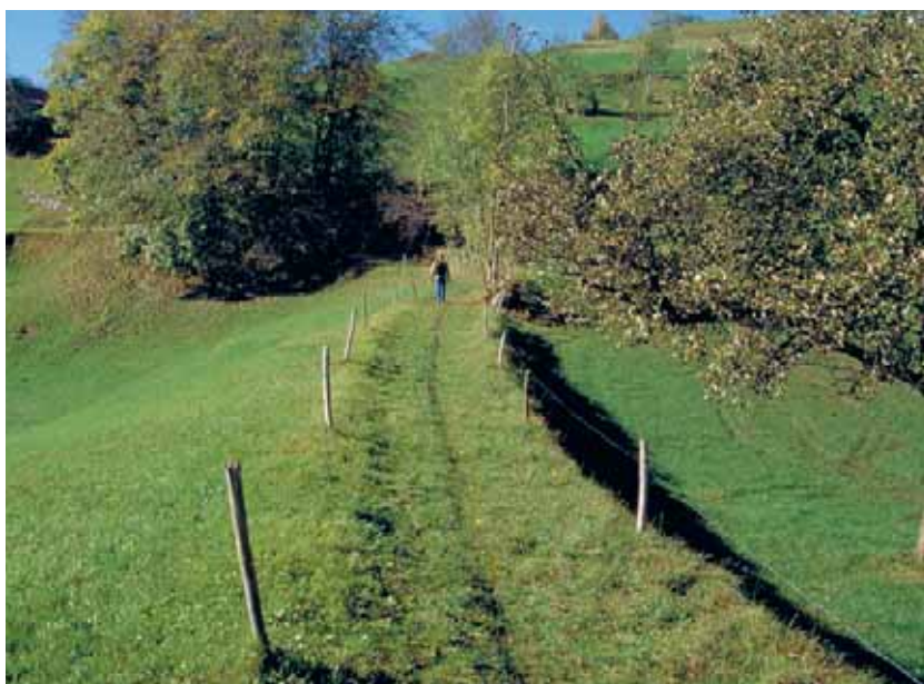
La «Chüegass» sul Grabserberg SG ha una pendenza regolare grazie al terrapieno (ViaStoria/Andriu Maissen).
